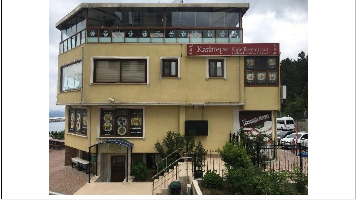
Şekil 5.62: Karlitepe Merkez Camii Restoran Binası
