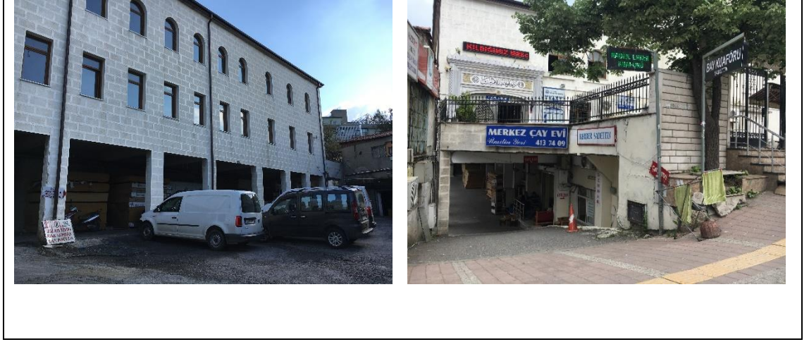
Şekil 5.32: Camiye Ait Bodrum Katındaki Ticari Mekanlar
