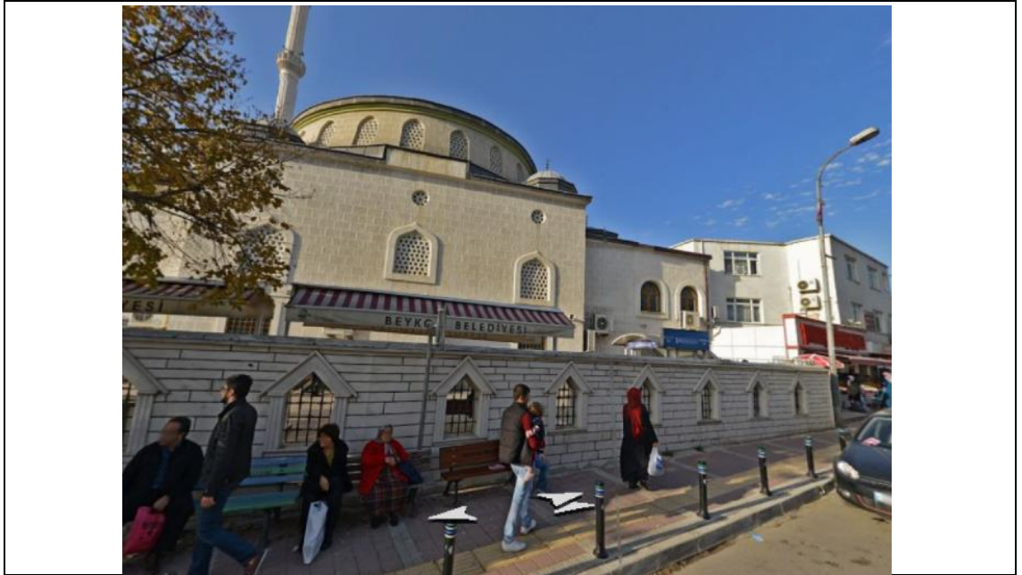
Şekil 5.29: Hasan Yavuz Camisi Sokak Görünümü
