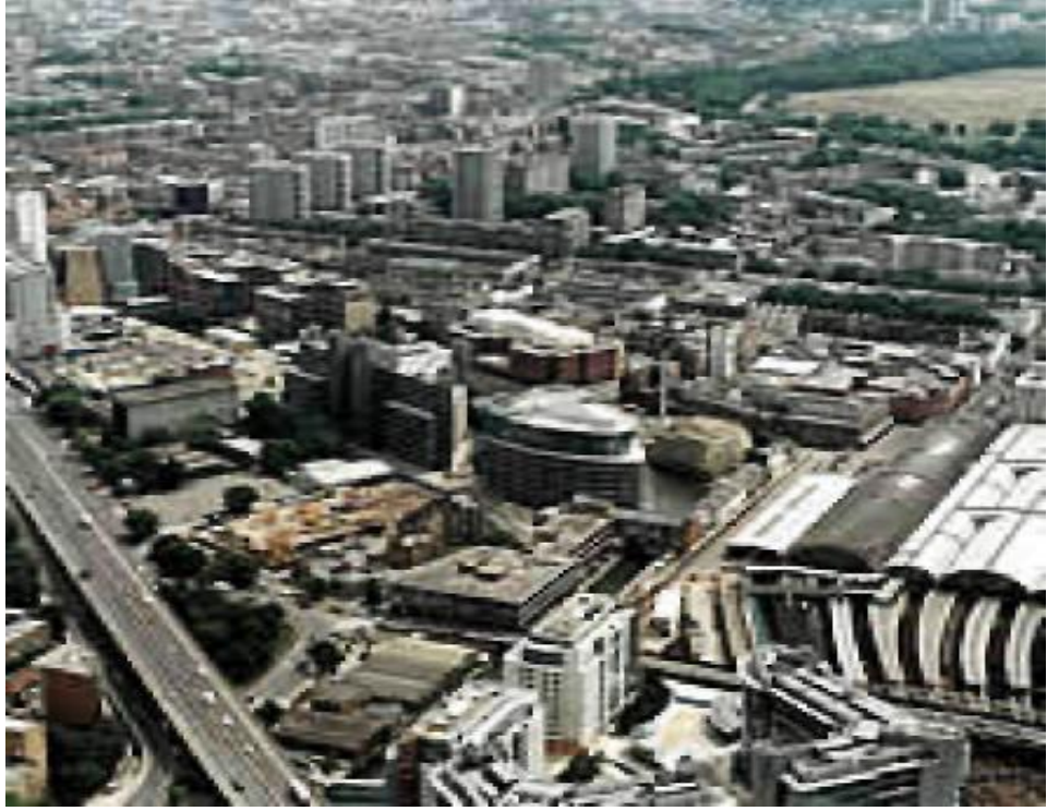
Şekil 2.12 : Paddington bölgesi genel görünüş
