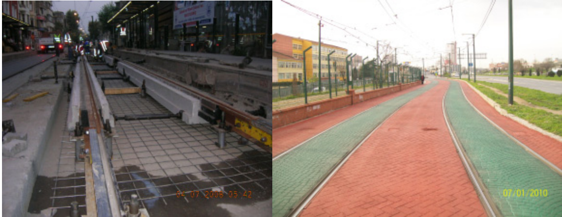
Şekil 4.33: Çemberlitaş istasyonu gömülü yol çalışması
