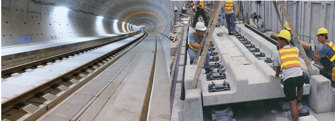
Şekil 4.29: Porr prekast üst yapı
