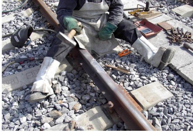
Şekil 6.33 : Kaynak dolgu işlemi
