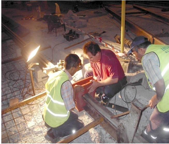
Şekil 6.20 : Termit kaynağında kalıbın bağlanması
