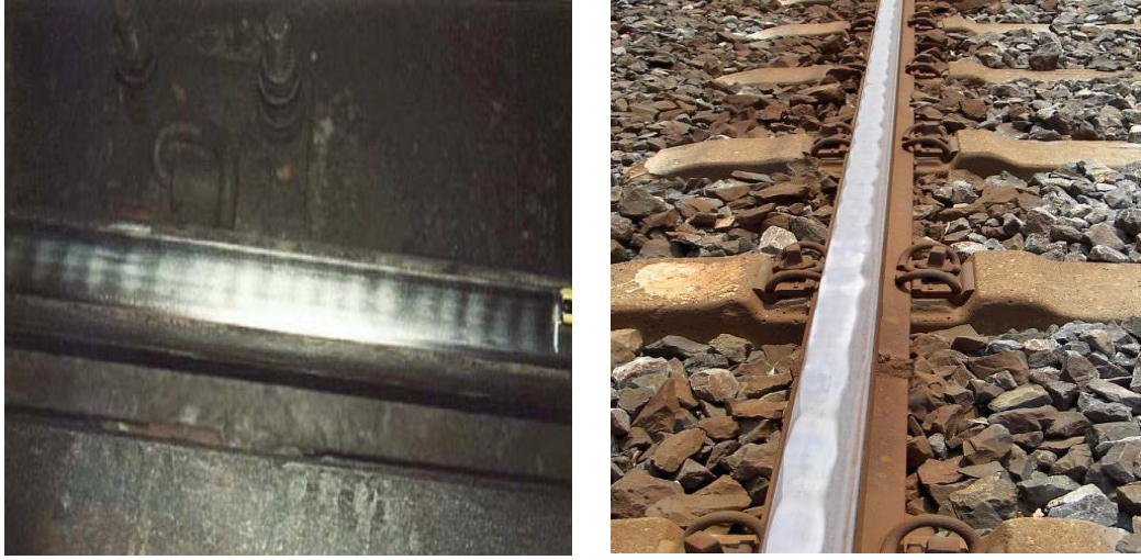
Şekil 6.2: Kısa ve uzun dalgalı ondülasyon
