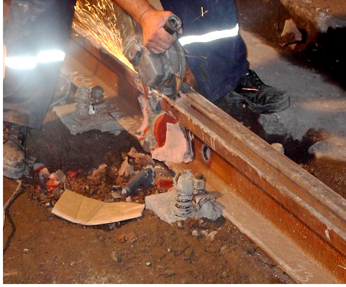
Şekil 6.26 : Sıyırma işlemim tamamlanmış ray
