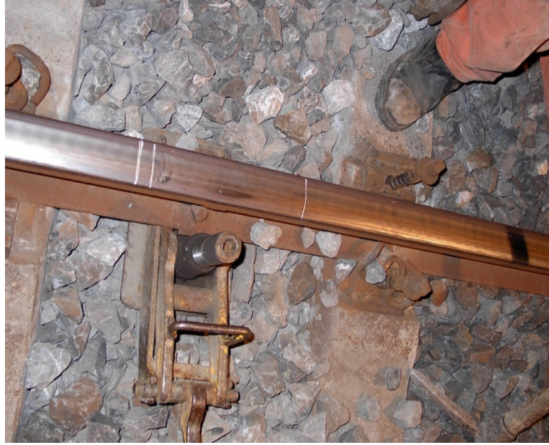
řekil 6.29 : Dolgu kaynaęı yapılacak blge
