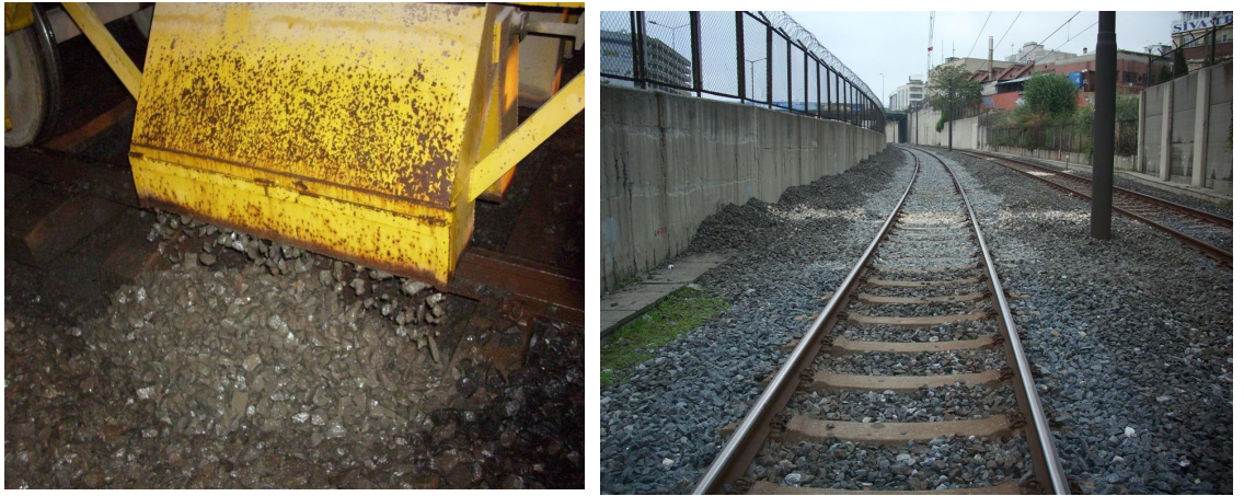
Şekil 6.41: Elenmiş balastın hatta dökülmesi
