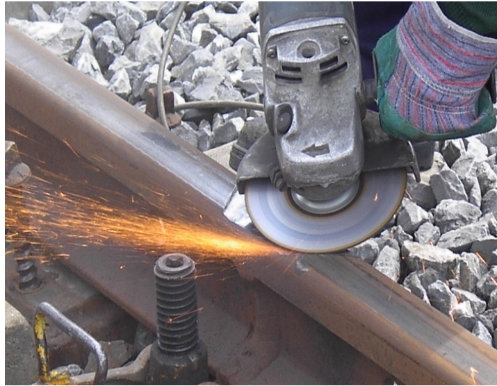
Şekil 6.30 : Kaynak ağızı açılması
