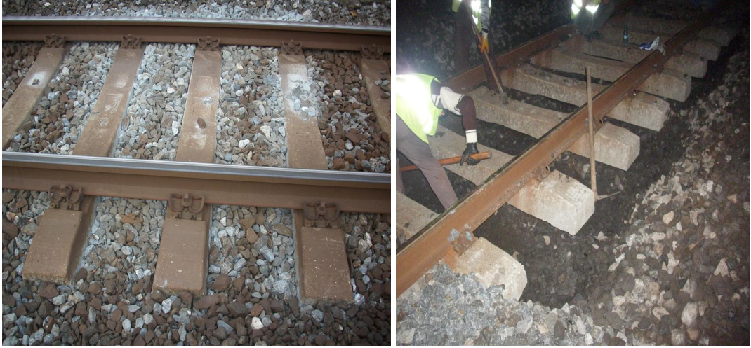
Şekil 6.40: Balast yatağının boşaltılması çalışması
