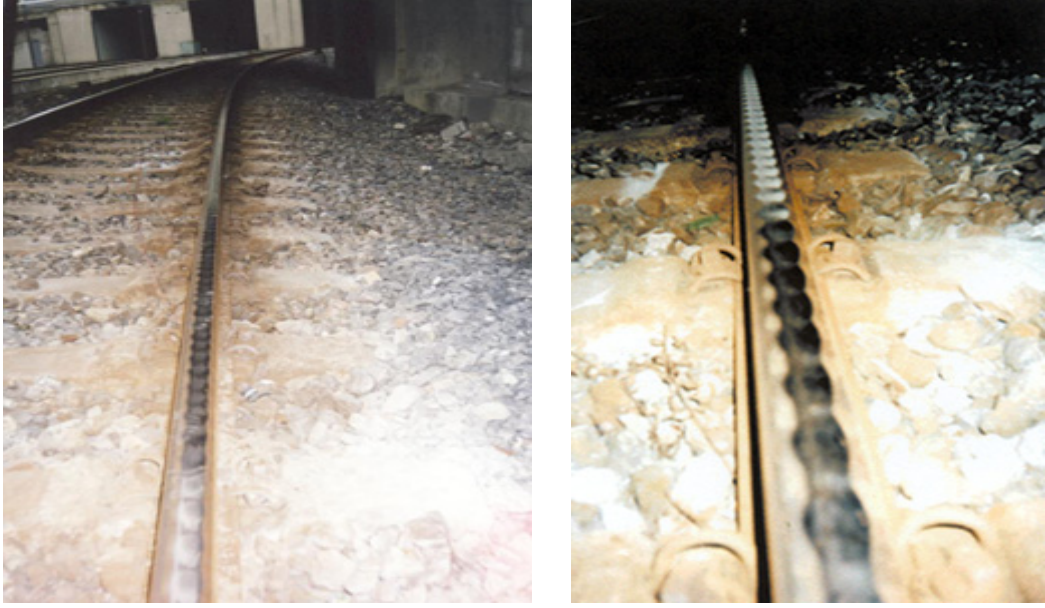
Şekil 5.15: Uğuldayan ray ondülasyon
