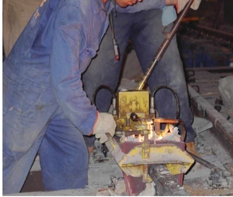
Şekil 6.25 : Thermit kaynağında ray sıyırma işlemi
