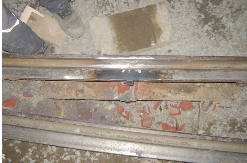
Şekil 6.27 : Termit kaynak yapılmış ray
