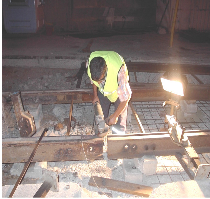
Şekil 6.18 : Ray yüzeyinin temizlenmesi
