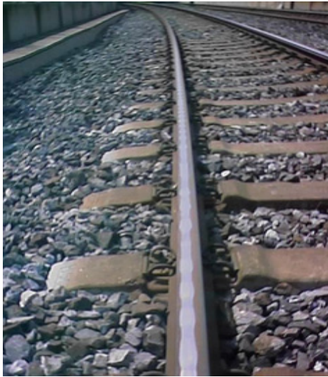
Şekil 5.14: Tekerlek izinden oluklanma
