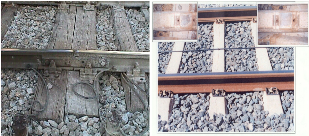
Şekil 5.3: Bozuk ve kırık travers
