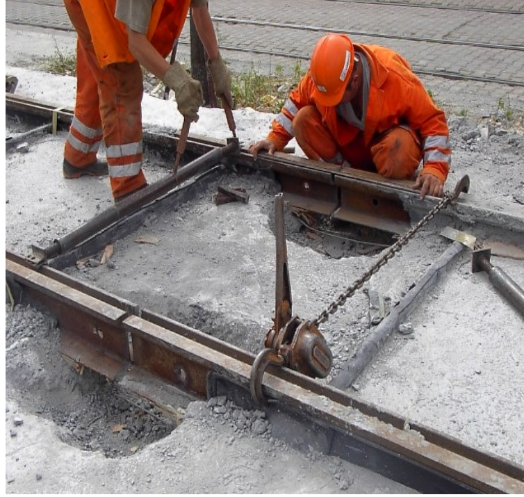
Şekil 6.19 : Kaynak öncesi rayların ayarlanması
