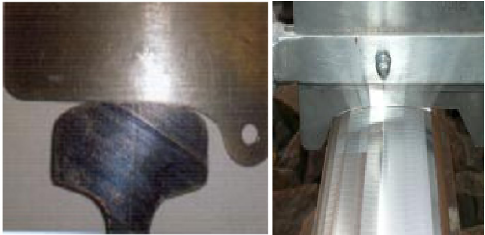
Şekil 6.16: Profil taşlama sonrası ray mantarının durumu
