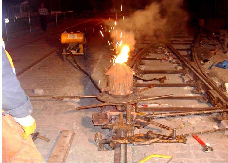
Şekil 6.23: Pota İçinde Termit reaksiyonunun oluşması
