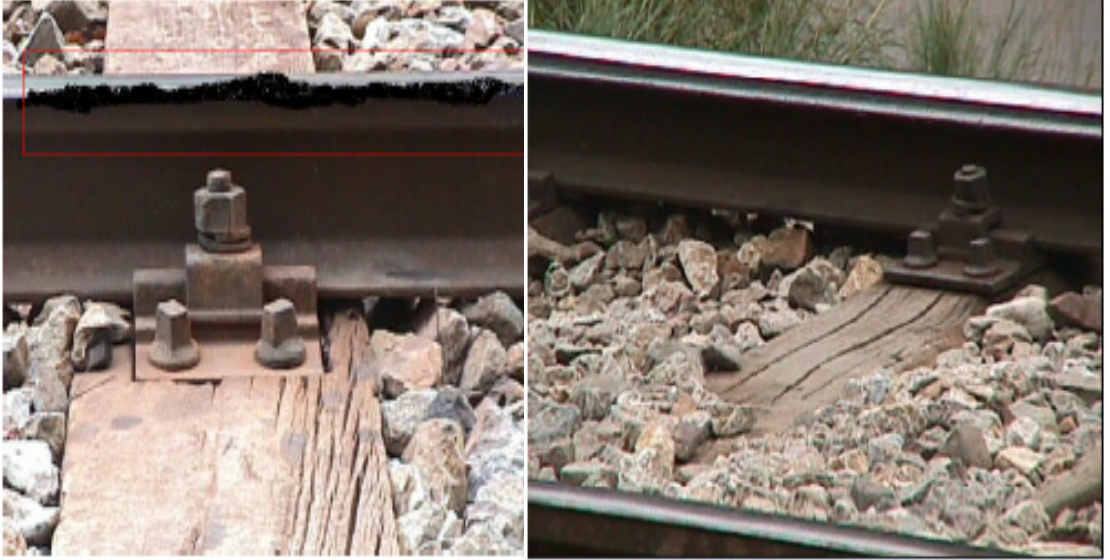
Şekil 5.4: Rayda aşınma ve kırılma
