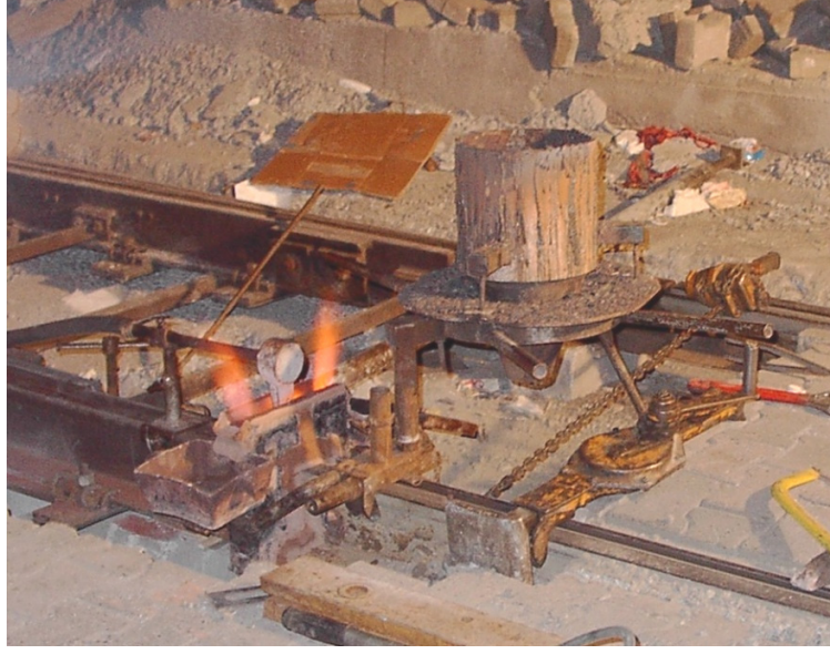
Şekil 6.22 : Potanın yerleştirilmesi
