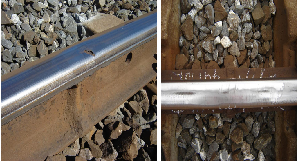
Şekil 6.28 : Dolgu kaynağı yapılacak ray
