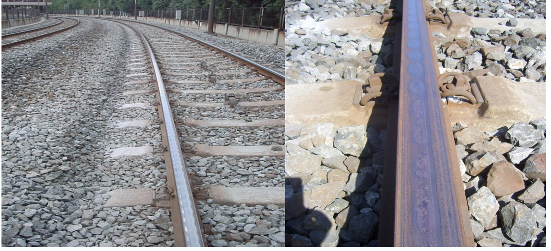
Şekil 6.15: Taşlama yapılacak hat
