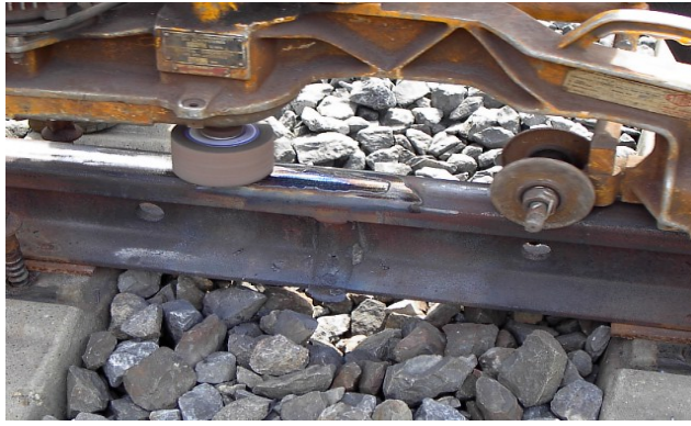
Şekil 6.34 : Kaynak sonrası taşlama
