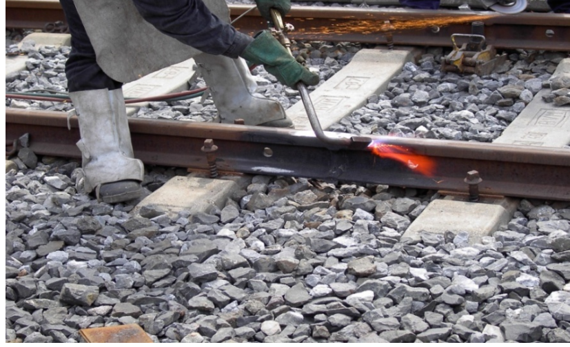
Şekil 6.31 : Ön ısıtma yapılması
