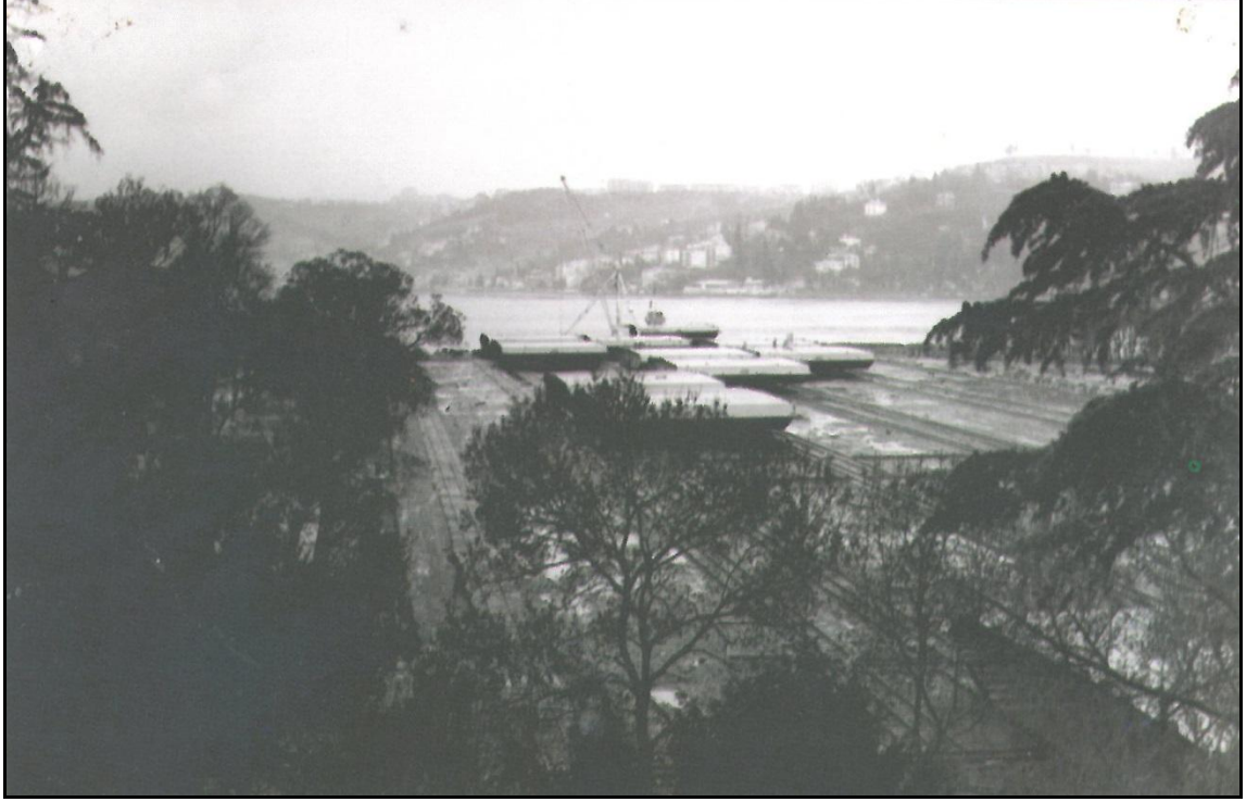
Şekil 4.26: Küçüksu mesire alanı birinci boğaz köprüsü şantiye ve montaj yeri halinde (Küçüksu koruluğunun güney yönündeki yeşil alan)
