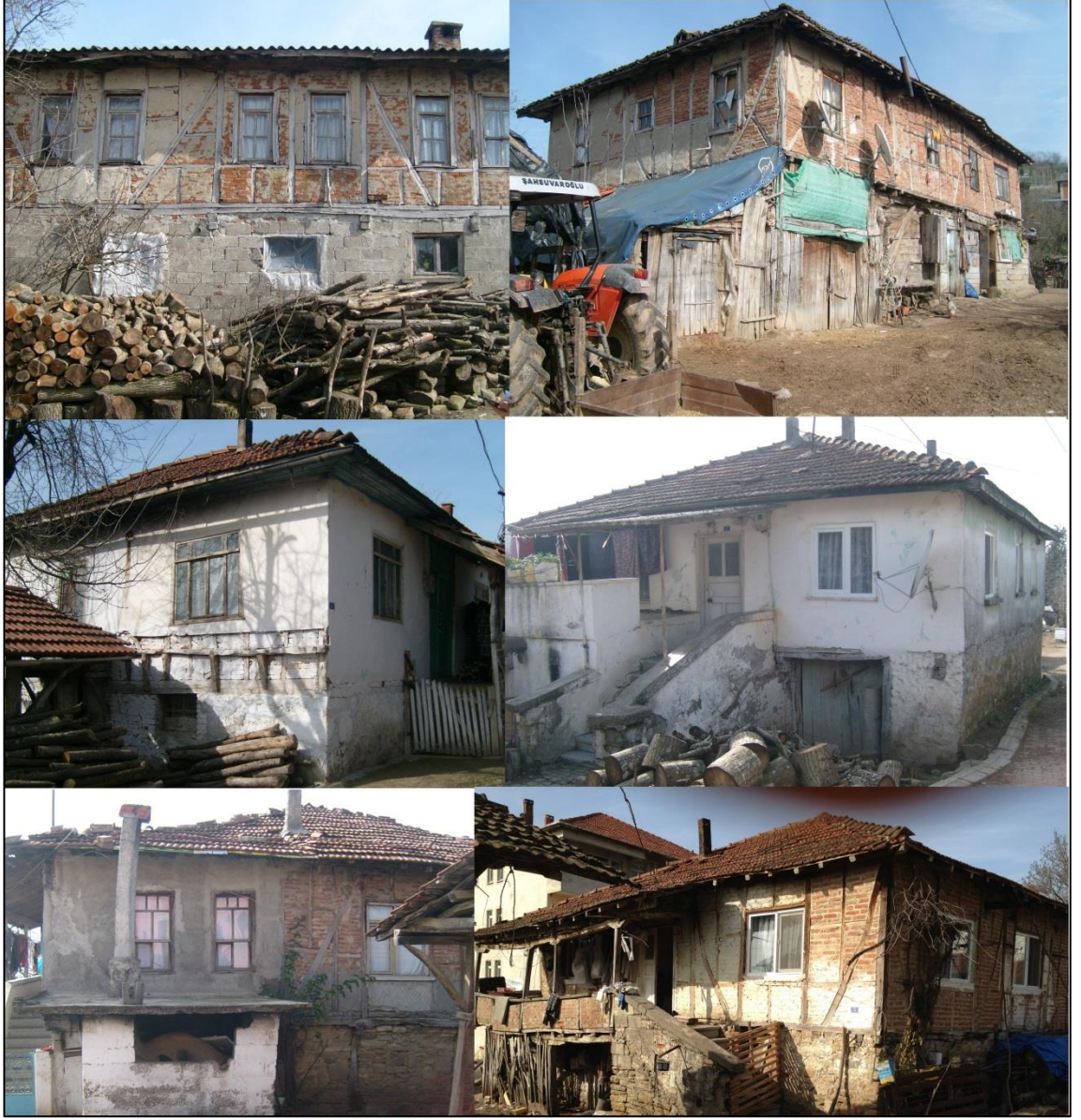
Şekil 4.8: Kaymaz (Araman) kırsal yerleşmesindeki klasik yapılar
