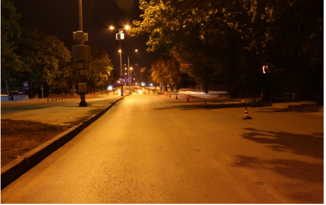
Şekil 10.1: HPS lambalarla aydınlatılan eski tesisat
