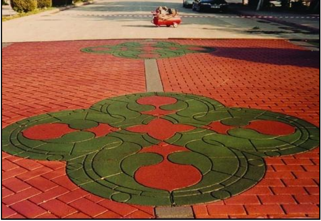
Şekil 4.31: Renkli desenli asfaltın baskı örneği
