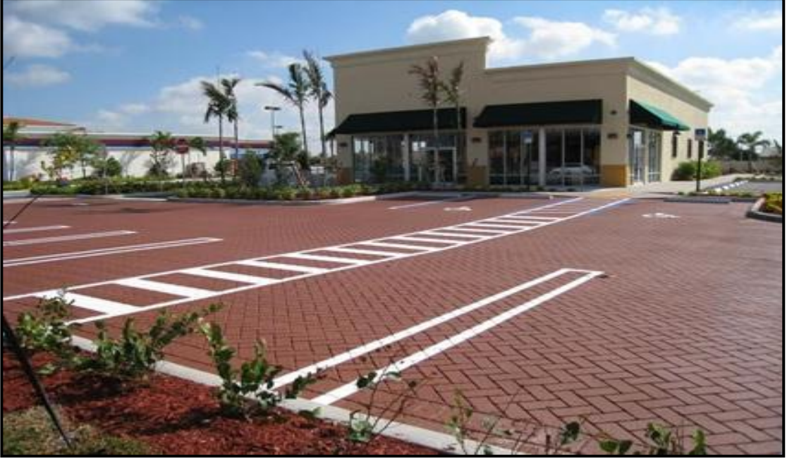
Şekil 4.25: Renkli desenli asfaltın şehir meydanlarında kullanımı
