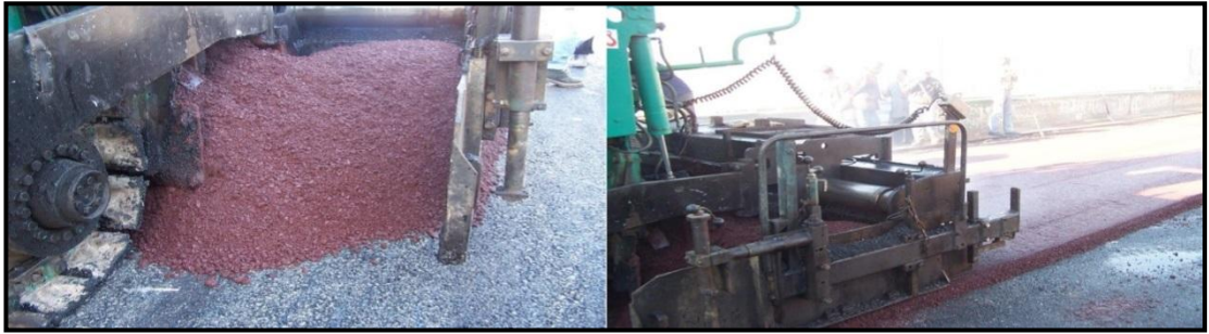
Şekil 4.37: Asfaltın serilmesi
