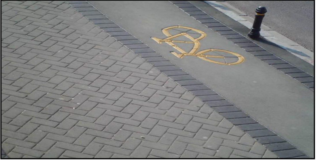
Şekil 4.23: Renkli desenli asfaltın yaya kaldırımlarında kullanımı
