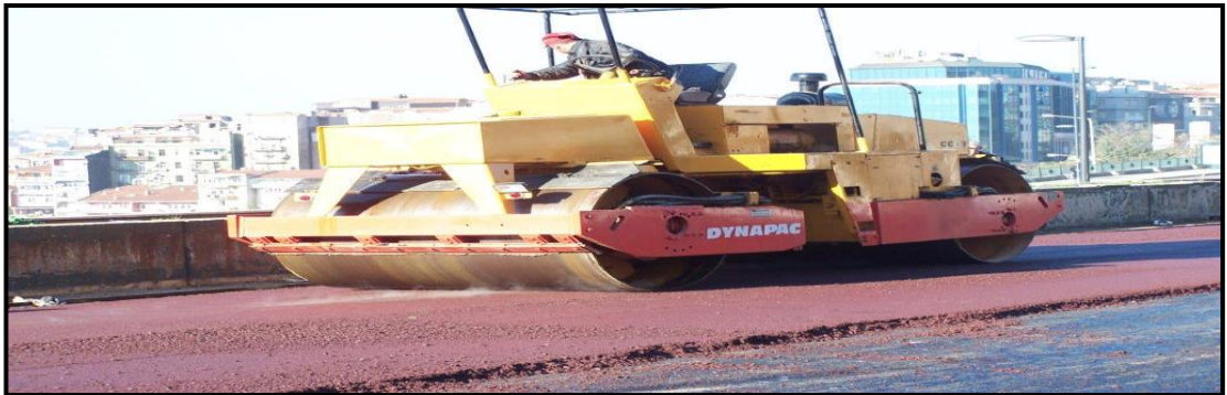
Şekil 4.38: Asfaltın sıkıştırılması
