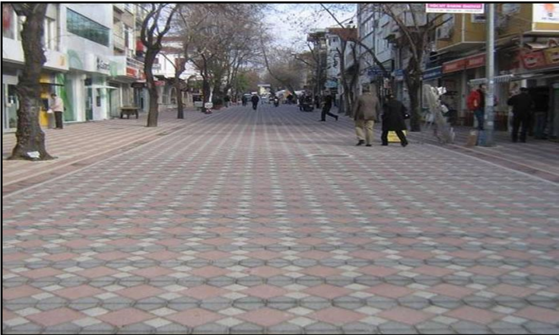
Şekil 4.5: Dekoratif kaplama sistemlerinde kuşlamalı beton parke kaplama kullanımı
