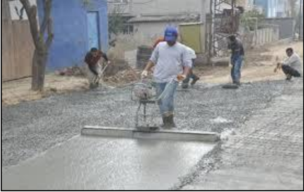
Şekil 4.7: Dekoratif kaplama sistemlerinde BS20 beton kaplama kullanımı
