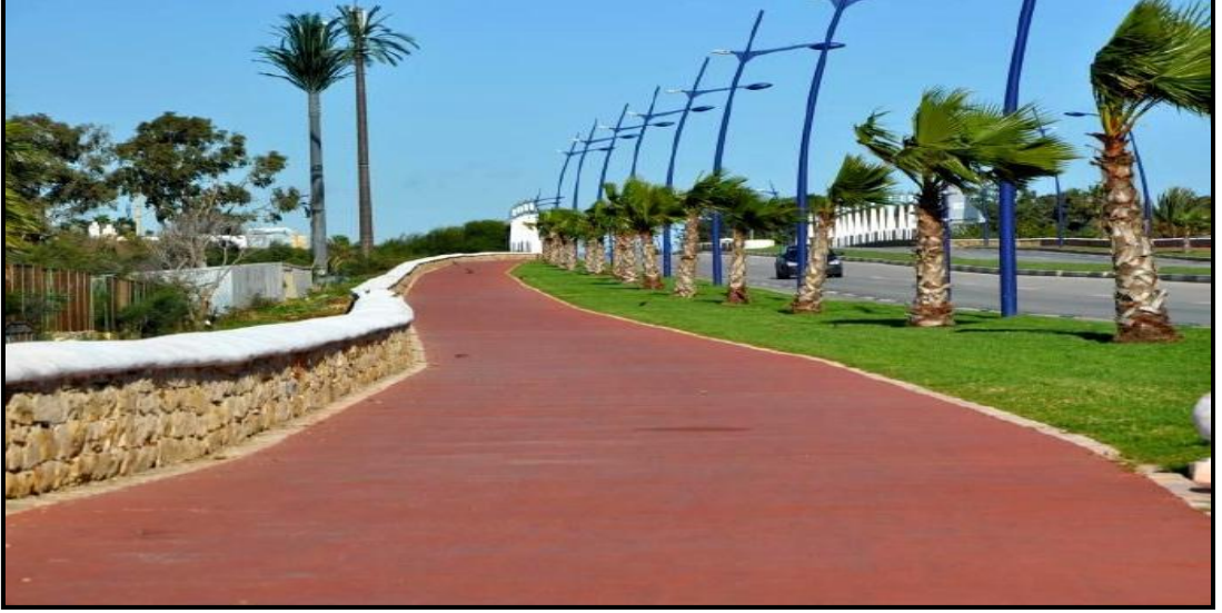
Şekil 4.20: Renkli mastik asfalt kullanımı
