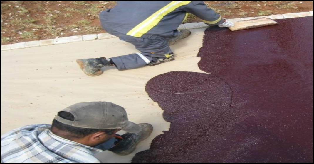
Şekil 4.21: Renkli mastik asfalt uygulaması
