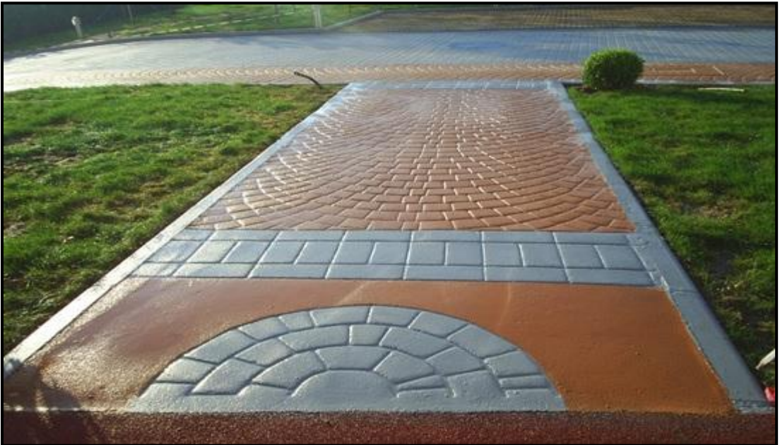
Şekil 4.26: Renkli desenli asfaltın şehir meydanlarında kullanımı
