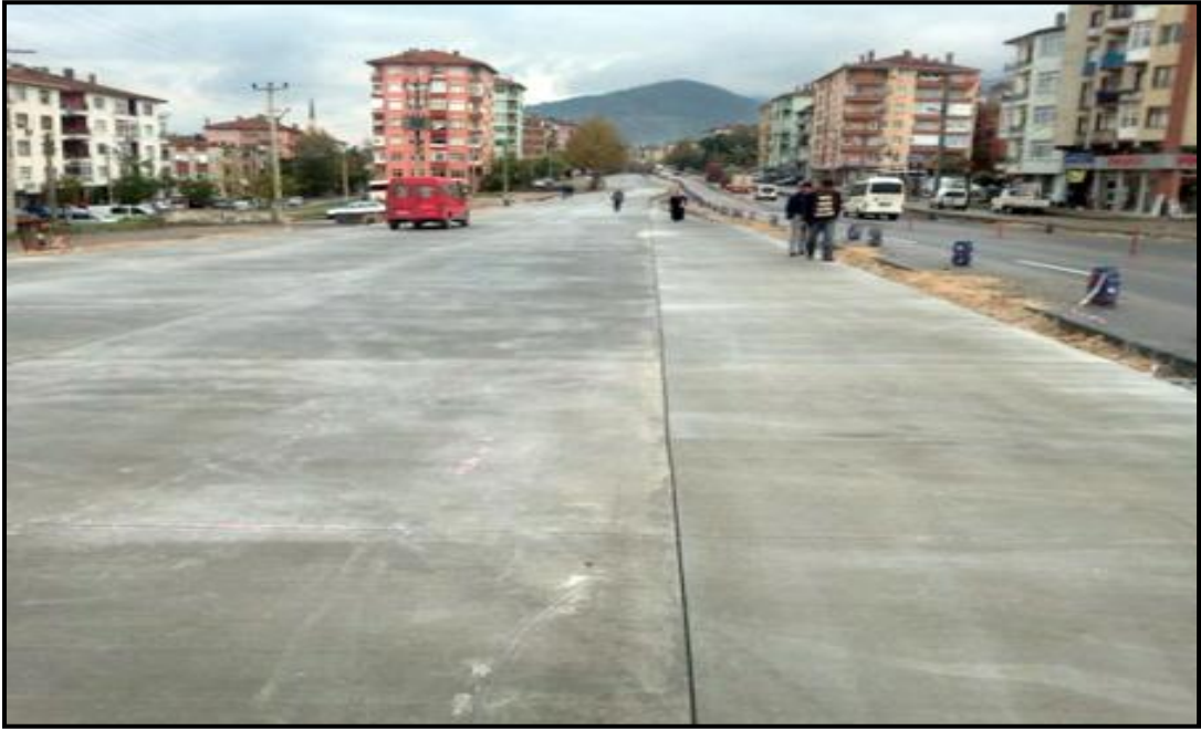
Şekil 4.8: Dekoratif kaplama sistemlerinde BS20 beton kaplama kullanımı
