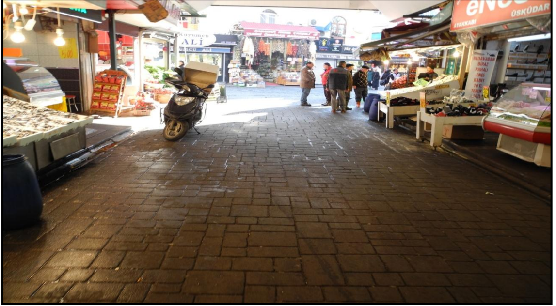
Şekil 4.33: Renkli desenli asfaltın Üsküdar'da kullanım örnekleri
