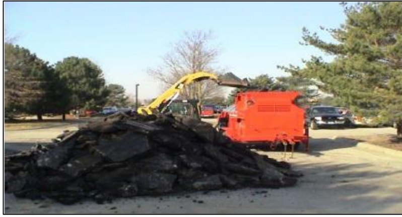
Şekil 4.6: Asfalt betonu kazıma ve sisteme yükleme
