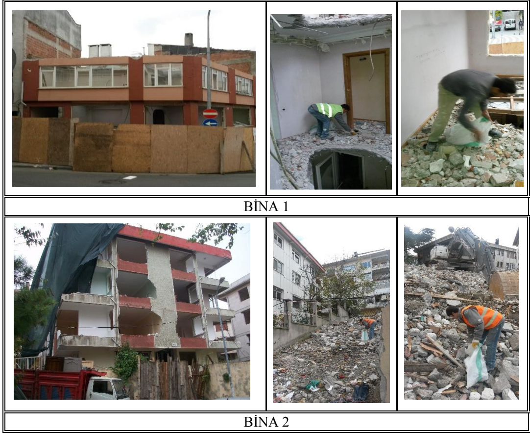
Şekil 6.2: Seçilen binalardan numune alımı
