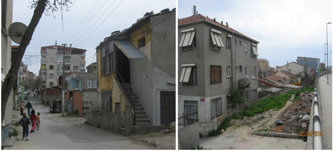
Şekil 4.6: Riskli alandaki fizik-mekan dokusu
