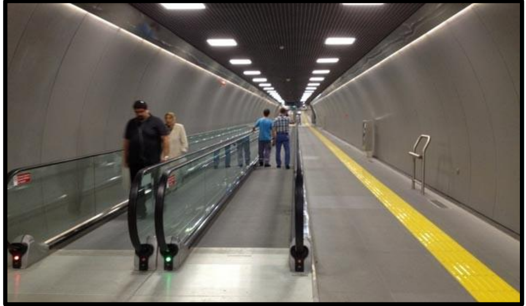
Şekil 5.6: Mecidiyeköy durağı metrobüs metro bağlantı tüneli
