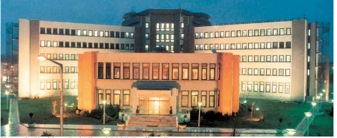
Şekil 6.1: Kadıköy Belediye Başkanlığı Binası.
