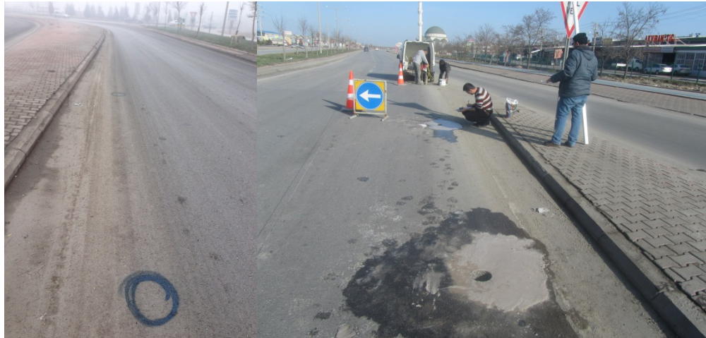
Şekil Ek A.32: Karot yerlerinin işaretlenmesi
