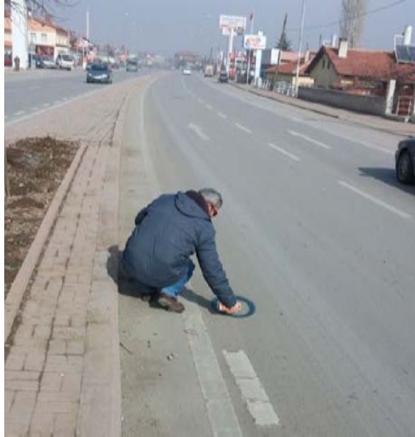
Şekil Ek A.20: Karot yerlerinin işaretlenmesi
