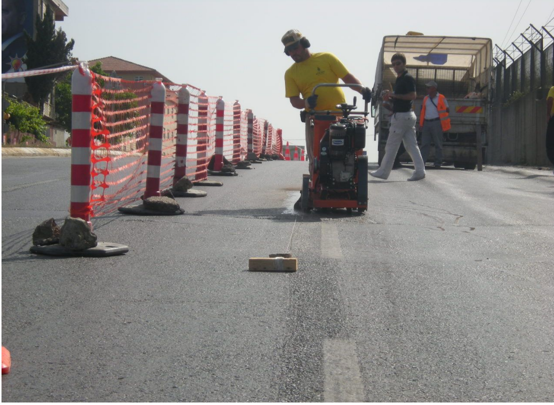
Şekil 4.17: Tuzla Aydınlı Yolu Caddesi karayolu üstyapısı bozulma örneği -2
