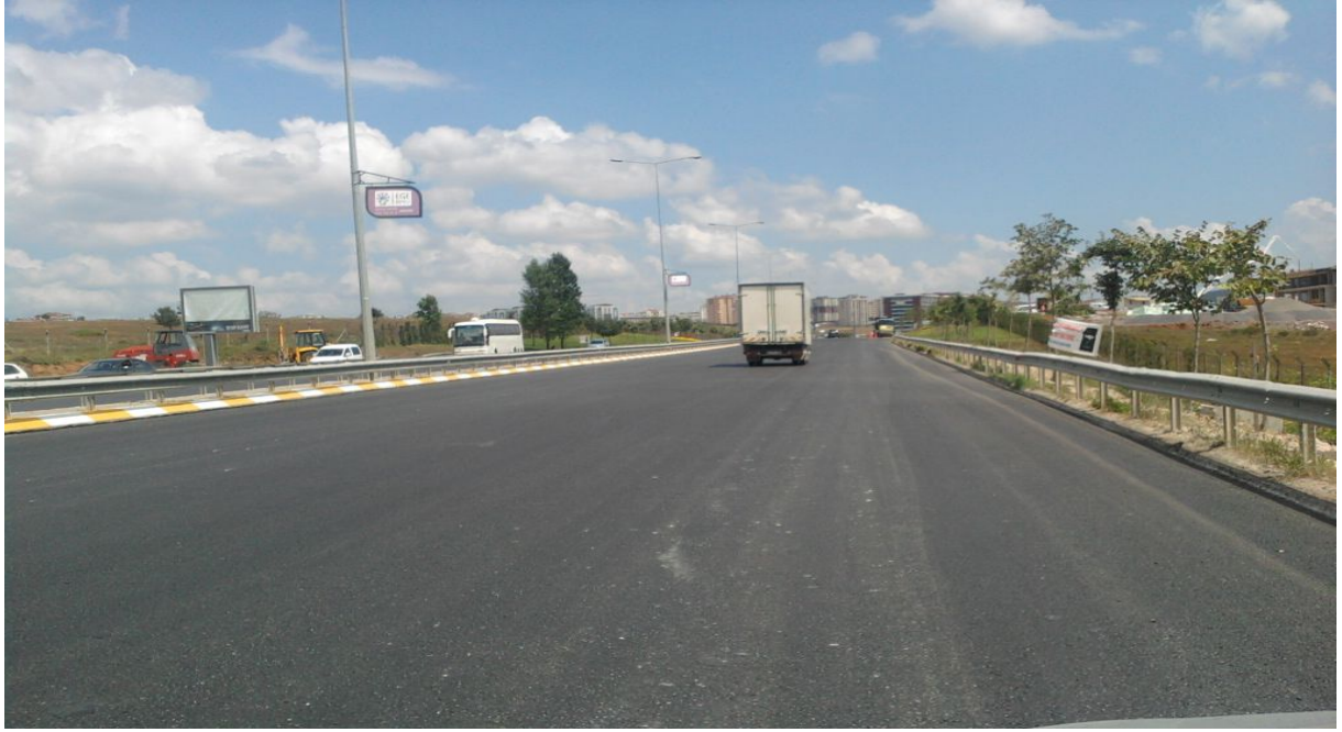
Şekil 4.5: Pendik havaalanı iç yolu karayolu üstyapısı bozulma örneği -3
