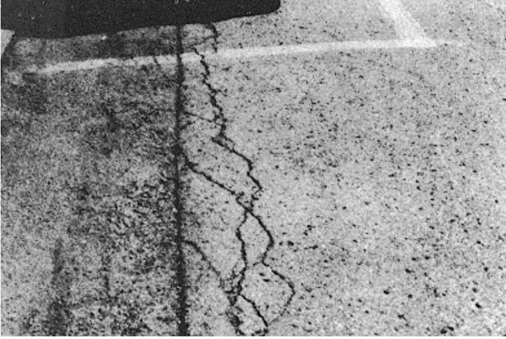
Şekil 3.9: Orta yoğunluklu kenar çatlağı
