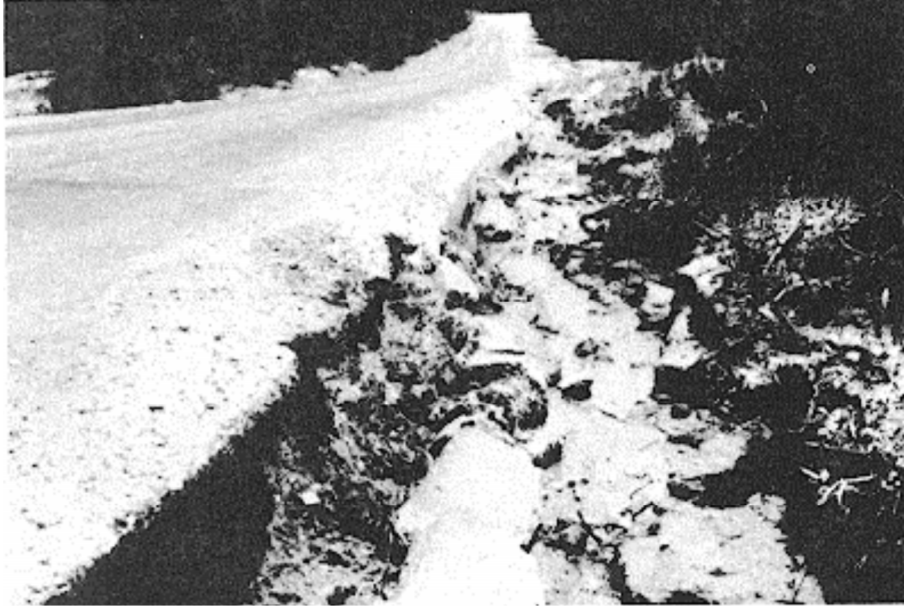
Şekil 3.45: Yüksek yoğunluklu kenar/banket düşüklüğü
