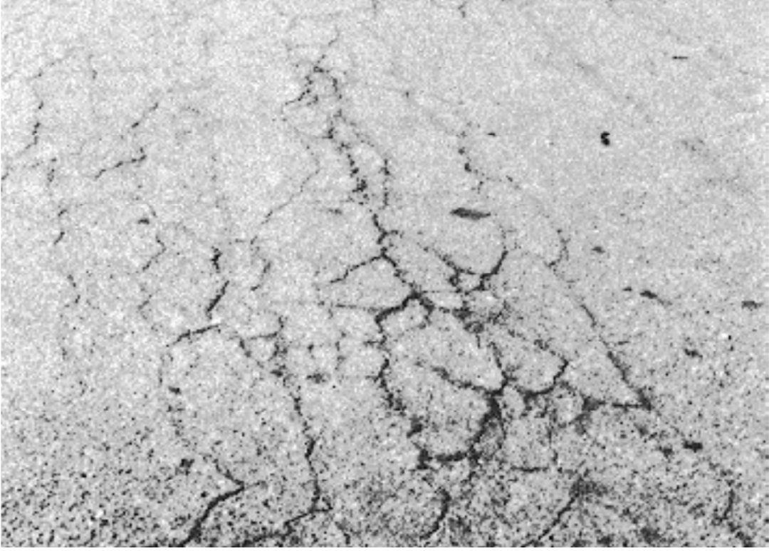
Şekil 3.3: Orta yoğunluklu yorulma çatlağı
