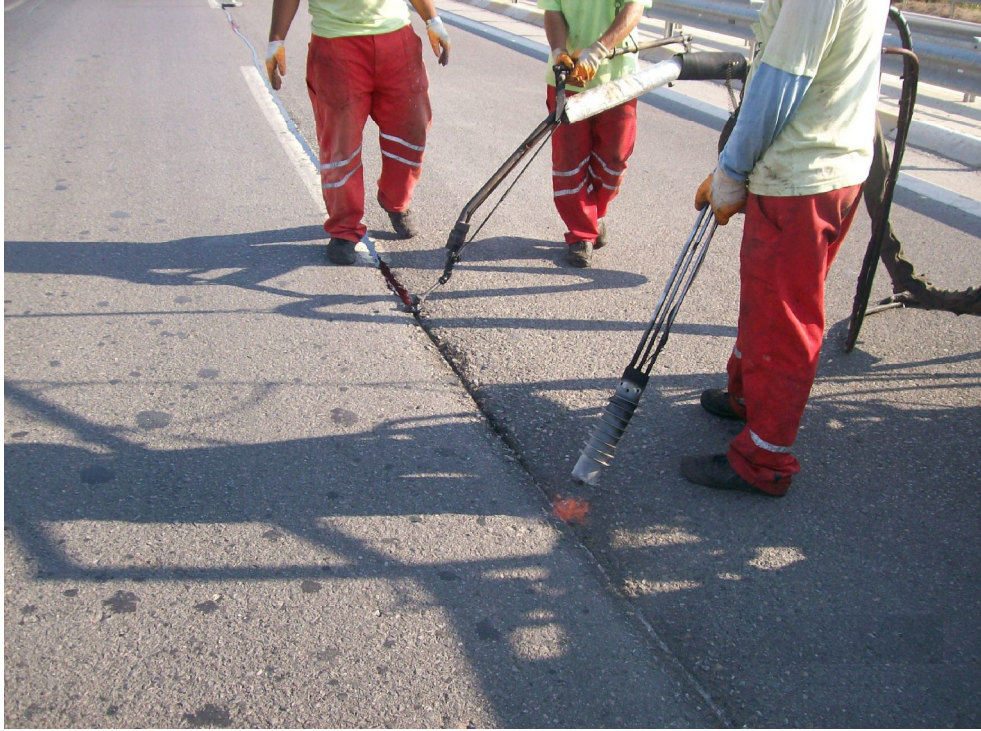
Şekil 4.7: Pendik Sabiha Gökçen TEM bağlantı yolu karayolu üstyapısı bozulma örneği
