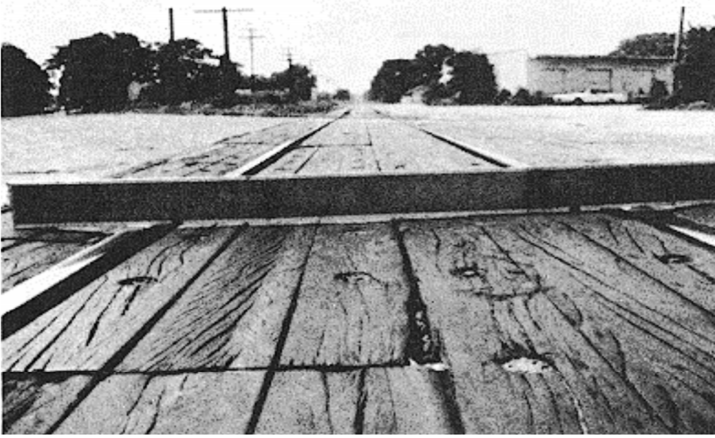
Şekil 3.37: Düşük yoğunluklu demiryolu geçişi
