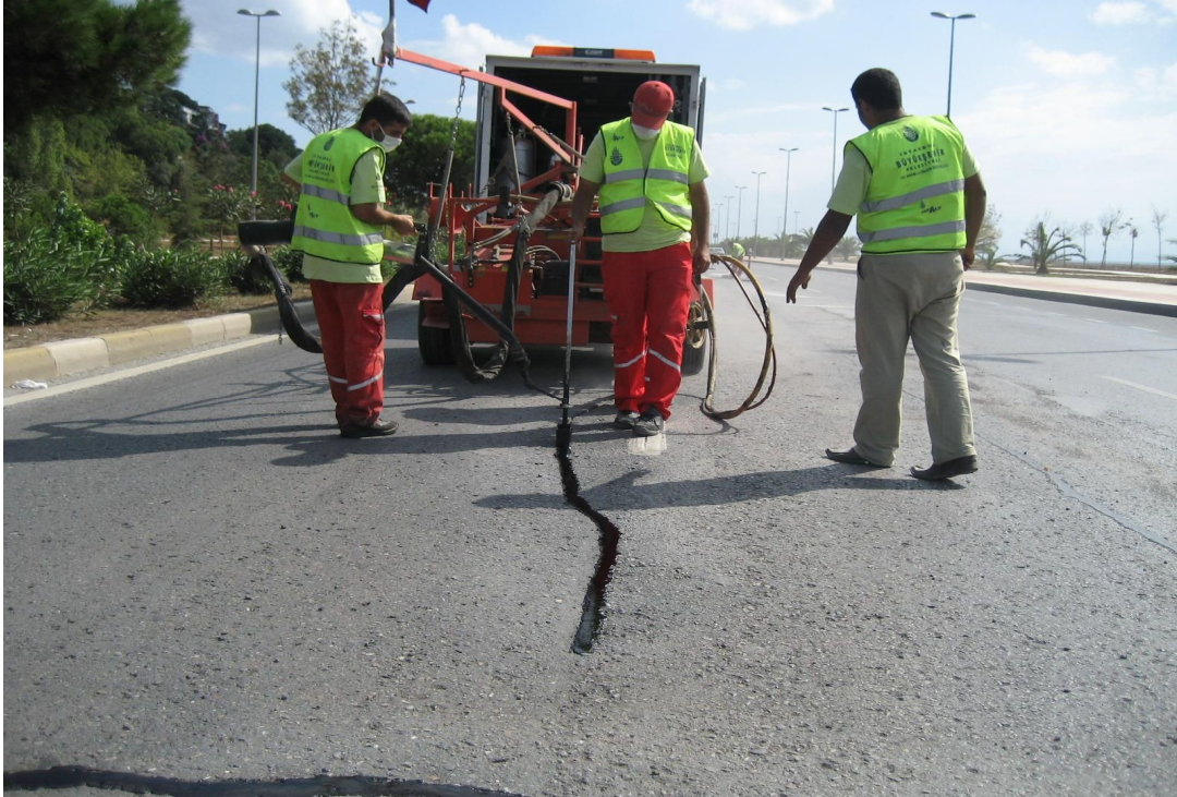
Şekil 4.11: Pendik sahil yolu karayolu üstyapısı bozulma örneği -3
