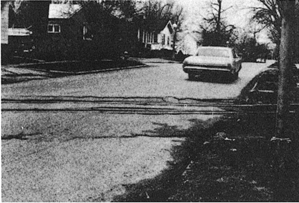
Şekil 3.39: Yüksek yoğunluklu demiryolu geçişi
