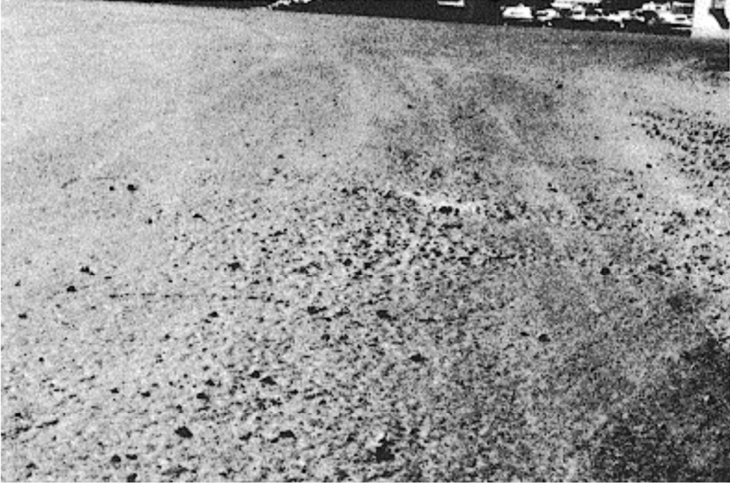
Şekil 3.54: Orta yoğunluklu sökülme ve ayrışma
