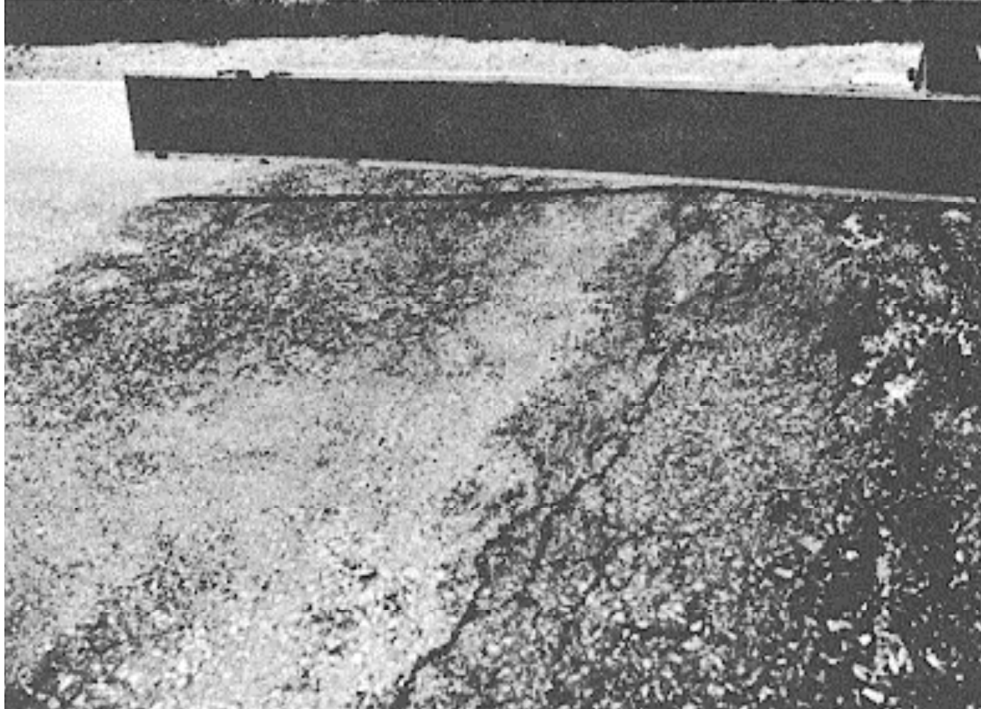
Şekil 3.30: Yüksek yoğunluklu kabarma ve oturma
