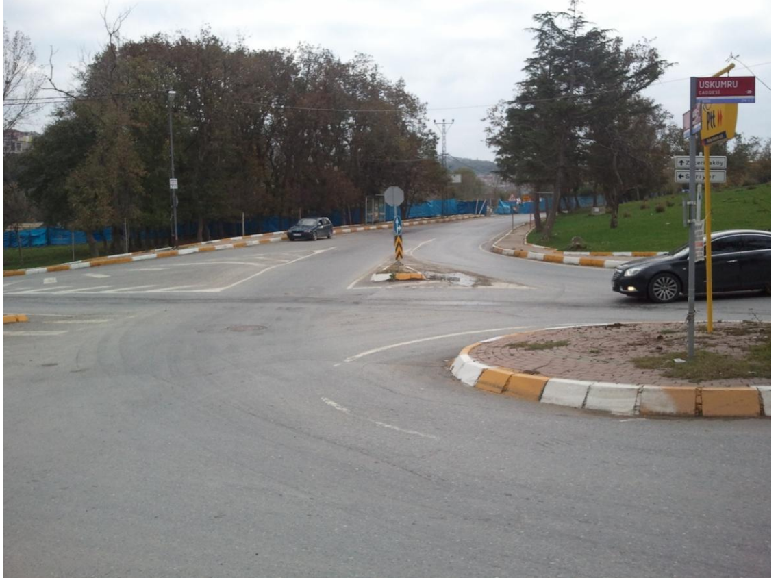
Şekil 4.13 İstanbul İli Sarıyer İlçesi, Zekeriyaköy Mahallesi, 1.Cadde 2 no'lu fotoğraf Kaynak: İbb arcmap verileri
