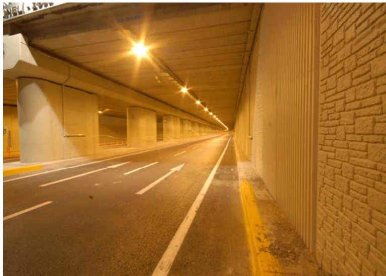
Şekil 5.16 Tünel Gece Aydınlatması
