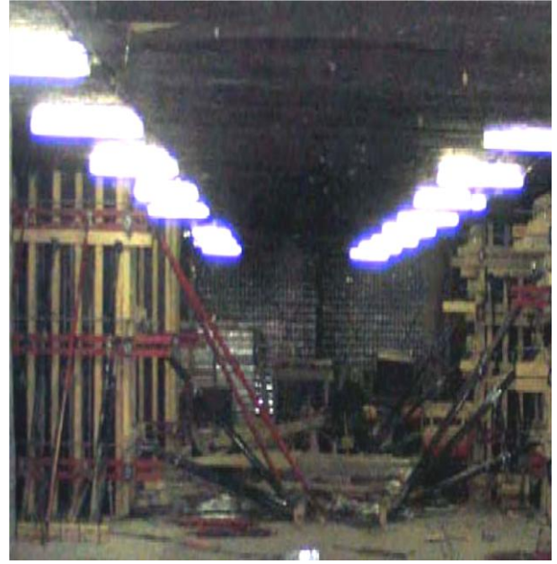
Şekil 5.58:Diyafram Kolon İmalatı
