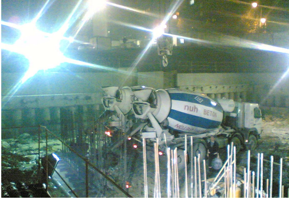
Şekil 5.38: Beton Dökümü
