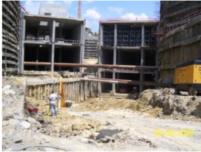
Şekil 6.28:Strut İmalatı
