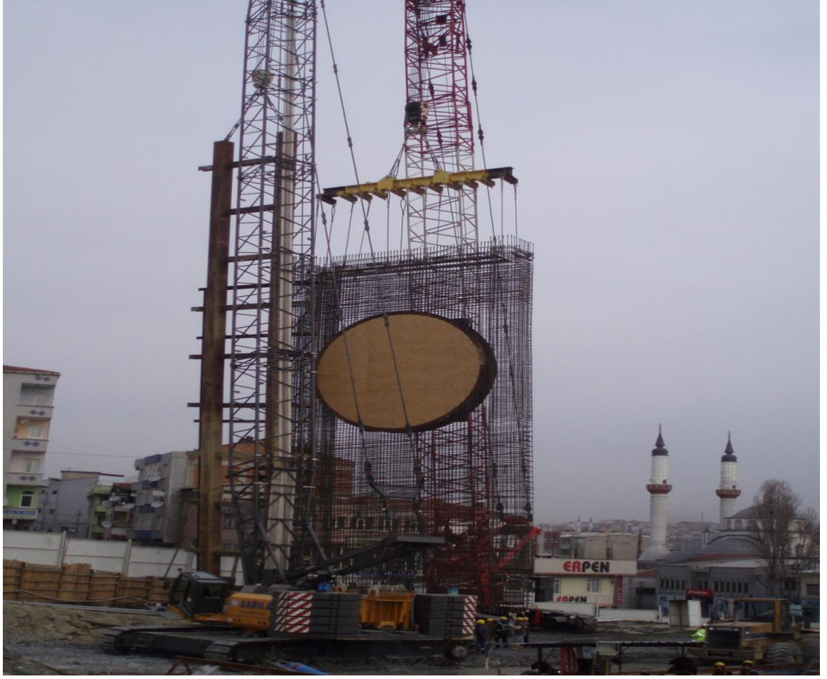
Şekil 5.31:Donatı Montajı
