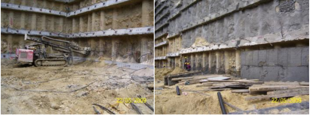
Şekil 6.29: Ankrajlı Perde Duvar İmalatı
