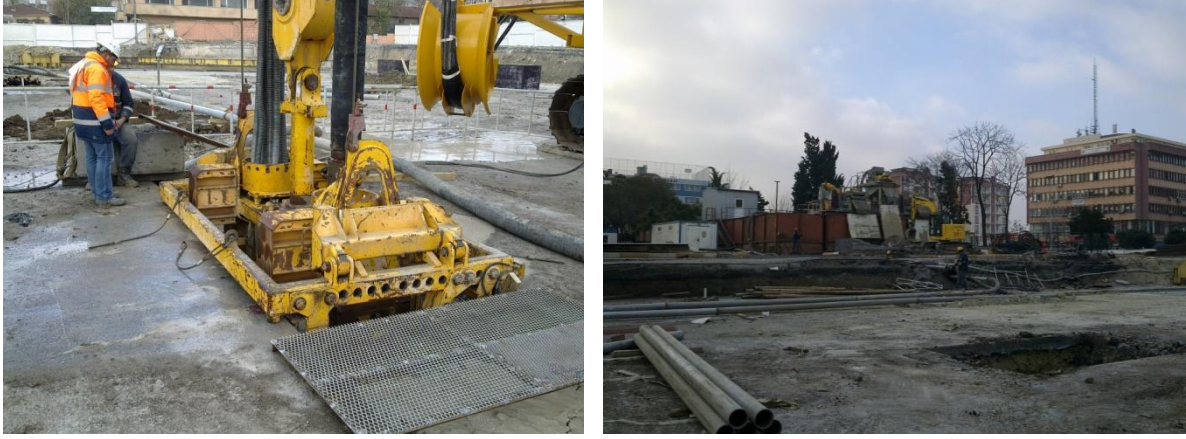
Şekil 5.26: Panel Kazısı
