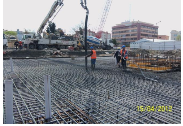
Şekil 5.44:Üst Kat Döşeme İmalatı
