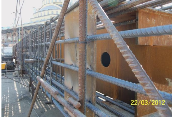
Şekil 5.34:Çelik Kolon Montajı
