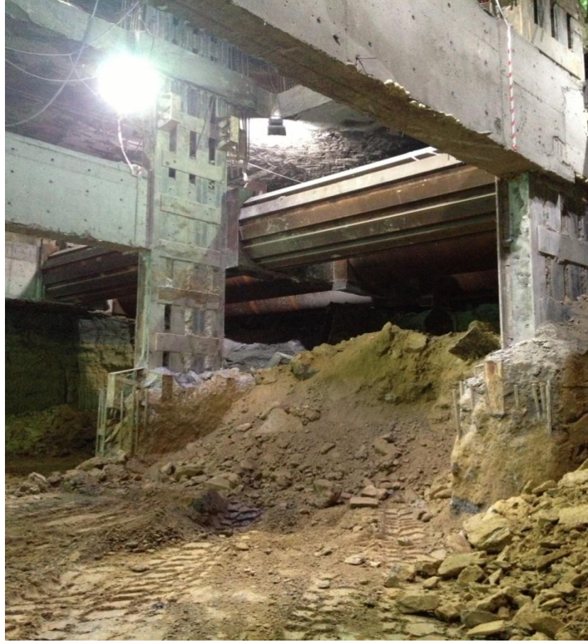
Şekil 5.54: Strut Montajı Ve Peron Katı Kazısı
