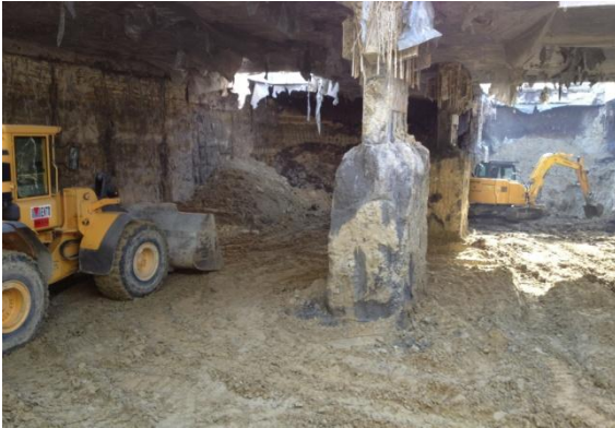
Şekil 5.47: Kapa-Aç Kat Döşeme Kazısı
