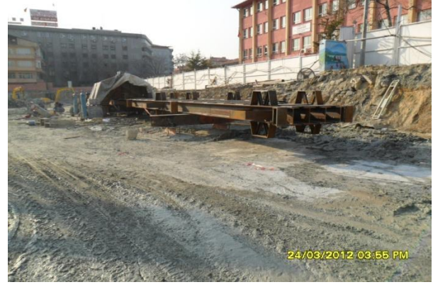
Şekil 5.34:Çelik Kolon Montajı
