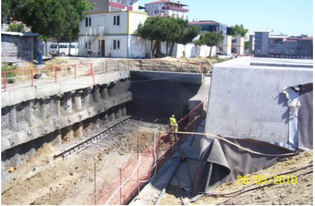
Şekil 6.25:El İle Shotcrete Uygulaması
