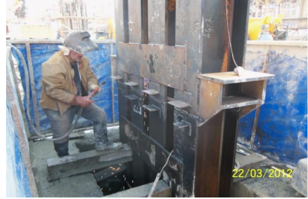
Şekil 5.35:Çelik Kolon Montajı
