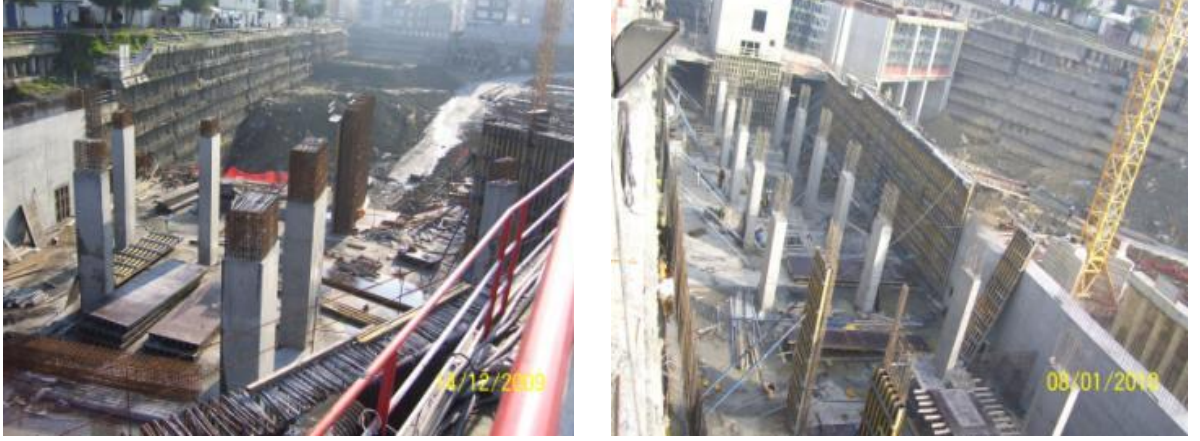
Şekil 6.50:Yüksek Kolon Ve Perde İmalatı
