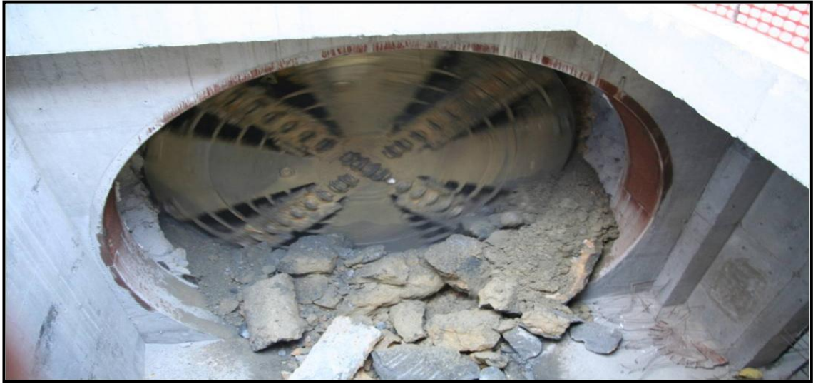
Şekil 3.13: TBM ' in İstasyon Yapısına girişi
