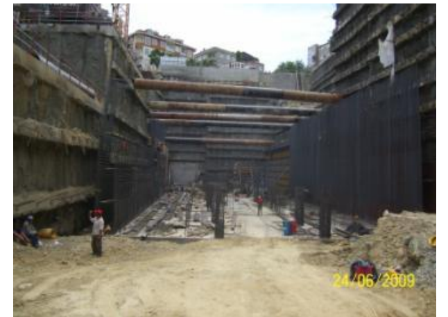
Şekil 6.31:Çelik Destekleyici Sistem İmalatları
