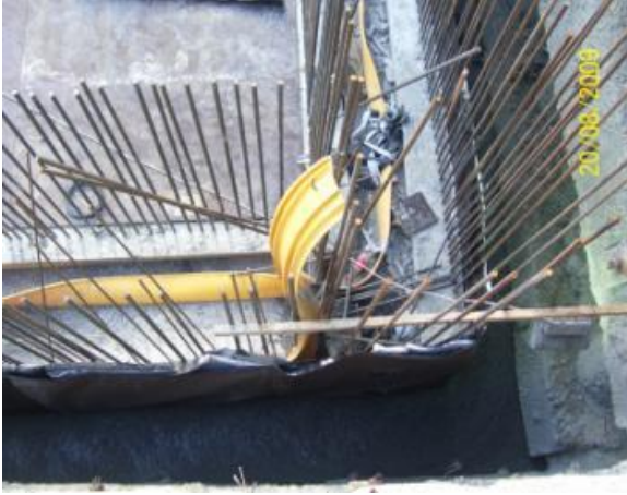
Şekil 6.44: Betonarme Perde Ve Su Tutucu Bant İmalatı
