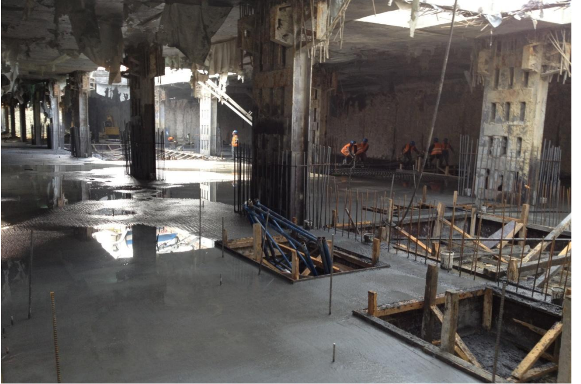
Şekil 5.53:Kat Döşeme Beton İmalatı
