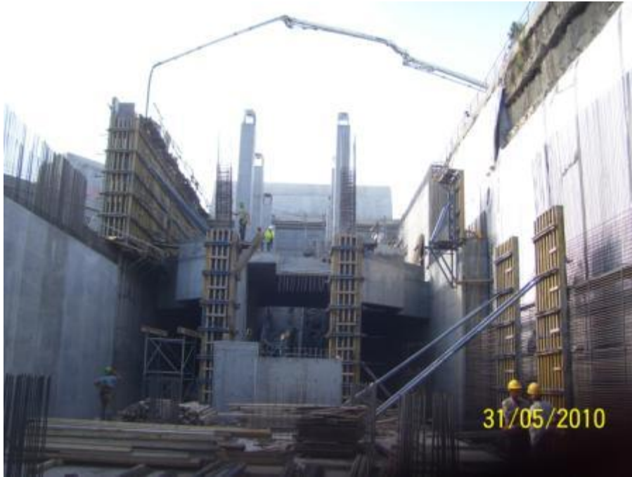
Şekil 6.45: Beton Dökümü
