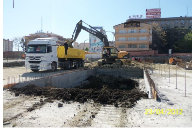
Şekil 5.46:Döşeme Altı Kazısı
