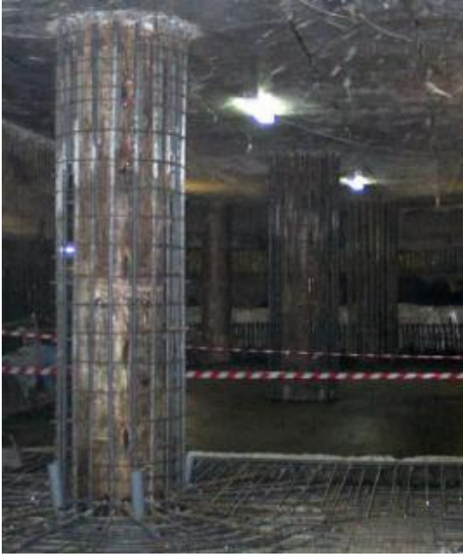
Şekil 5.57:Diyafram Kolon İmalatı
