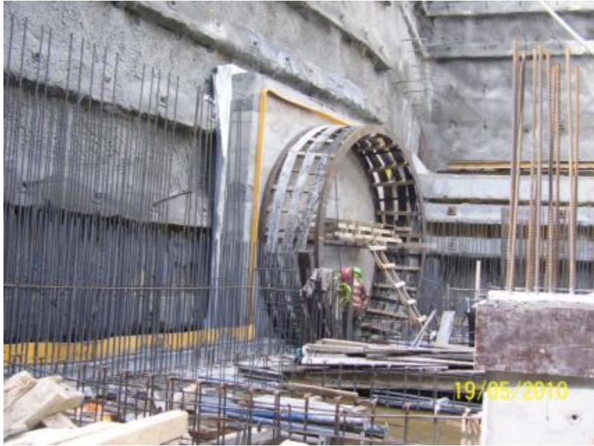
Şekil 6.43:Tünel Aynası Betonarme İmalatı
