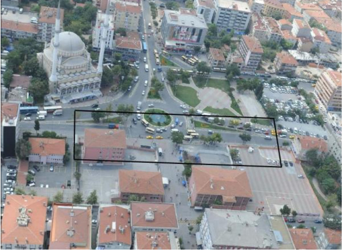
Şekil 5.2:Bağcılar İstasyon Yeri Havadan Görünüşü
