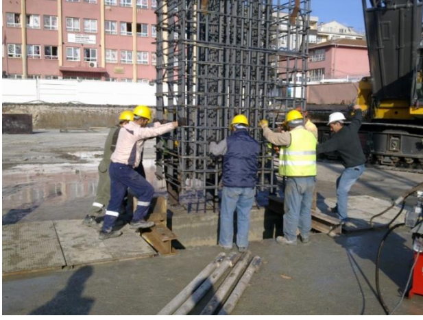
Şekil 5.33:Donatı Montajı
