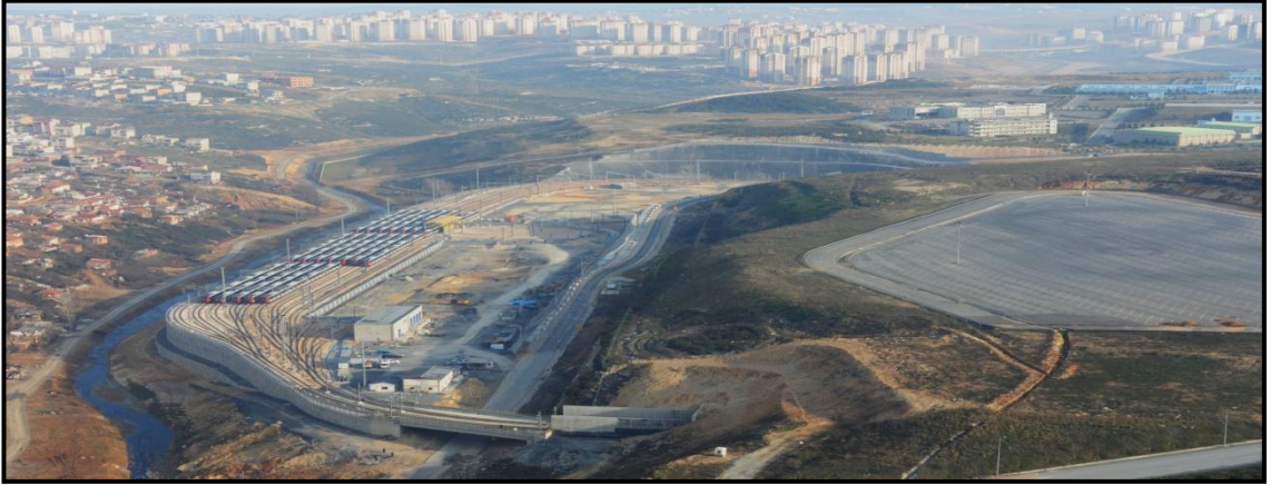
Şekil 3.7: Depo ve Atölye Sahası
