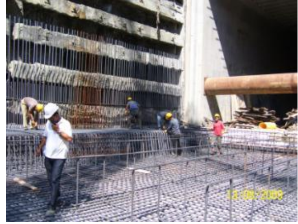
Şekil 6.38:Donatı Montajı
