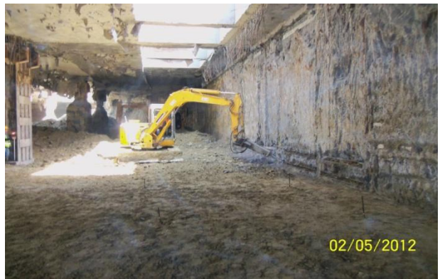
Şekil 5.47: Kapa-Aç Kat Döşeme Kazısı
