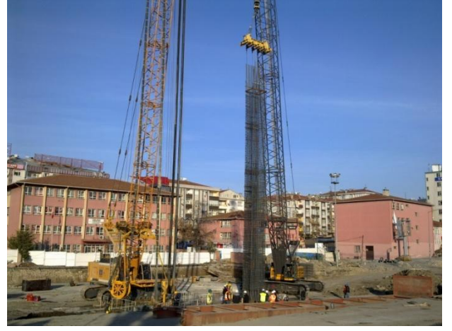
Şekil 5.33:Donatı Montajı
