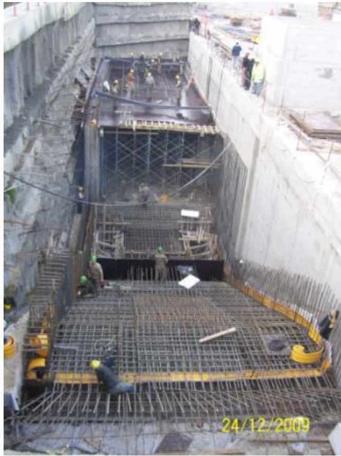
Şekil 6.39:Su Tutucu Bant Montajı
