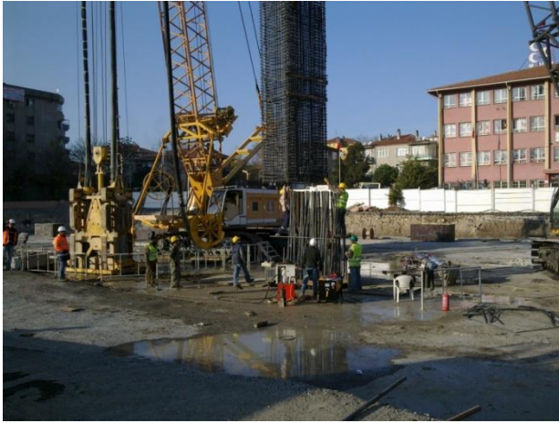
Şekil 5.32:Donatı Montajı
