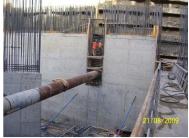
Şekil 6.44: Betonarme Perde Ve Su Tutucu Bant İmalatı
