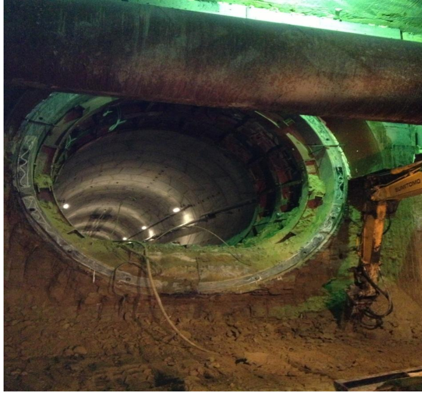
Şekil 5.55: Strut Montajı Ve Peron Katı Kazısı
