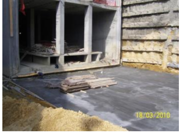
Şekil 6.33:Grobeton İmalatı
