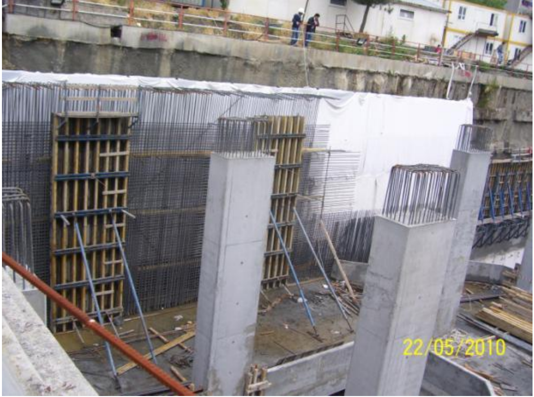
Şekil 6.41:Perde Ve Kolon İmalatı
