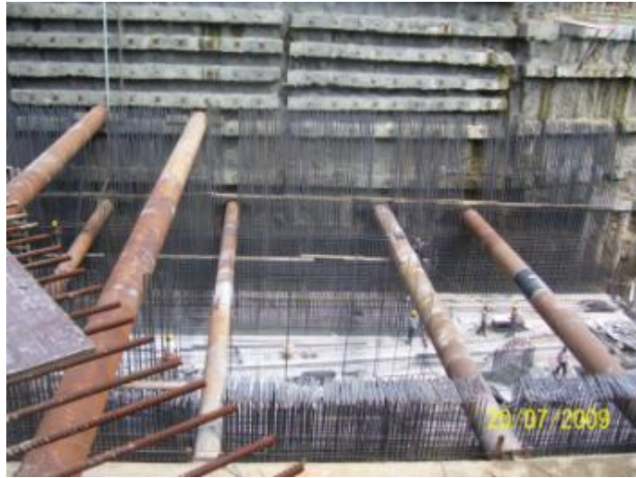
Şekil 6.40: Donatı Montajı
