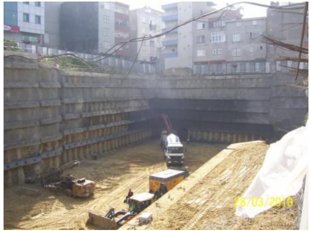
Şekil 6.24:Shotcrete Uygulaması
