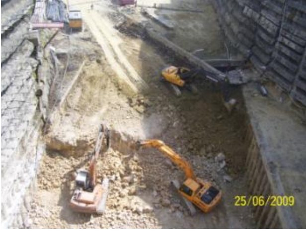
Şekil 6.23:Sert Zemin Kazısı
