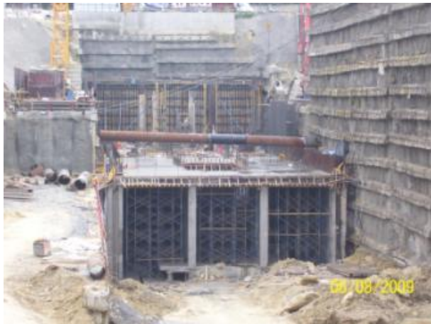
Şekil 6.31:Çelik Destekleyici Sistem İmalatları
