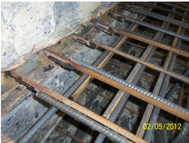
Şekil 5.49:Ara Kat Döşeme Donatı Montajı
