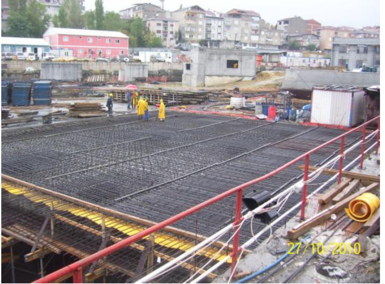
Şekil 6.53:Döşemede Soğuk Derz Ve Su Tutucu Bant İmalatı
