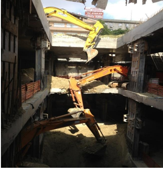
Şekil 5.48:Kapa-Aç Kat Döşeme Kazısı
