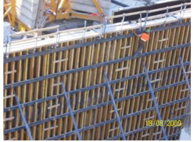
Şekil 6.42:Kalıp İmalatı
