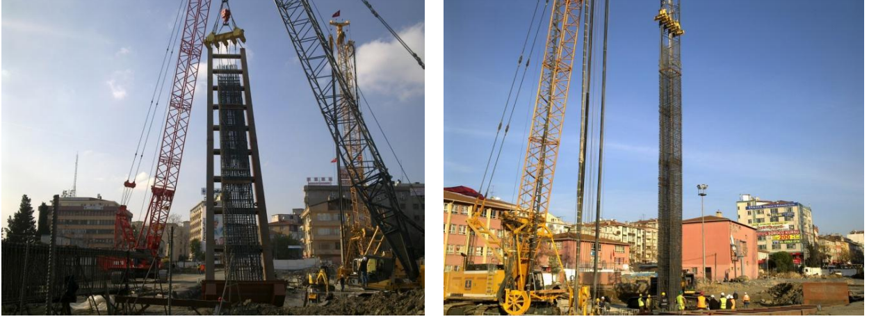
Şekil 5.30:Donatı Kafesi Montajı
