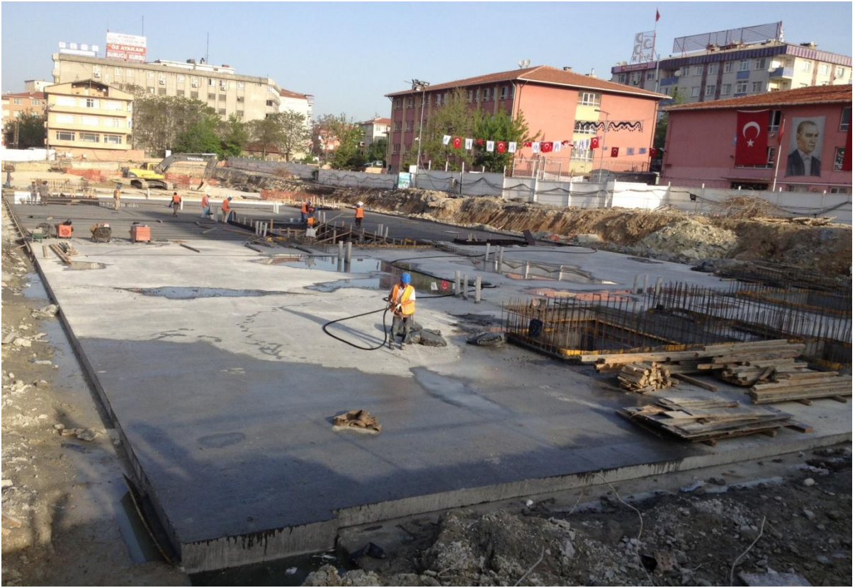
Şekil 5.45:Üst Kat Döşeme İmalatı
