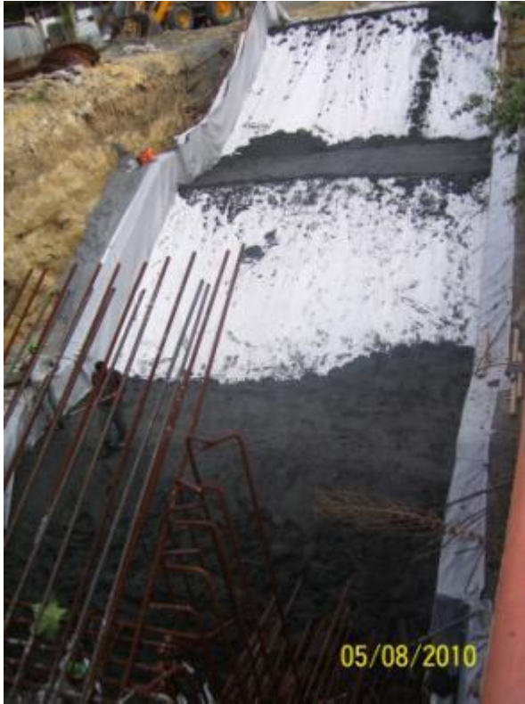
Şekil 6.37:Koruma Betonu
