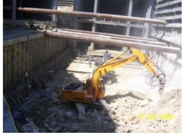
Şekil 6.23:Sert Zemin Kazısı
