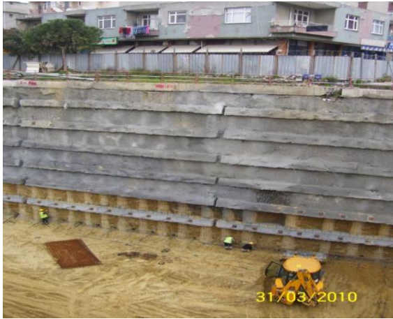
Şekil 6.24:Shotcrete Uygulaması
