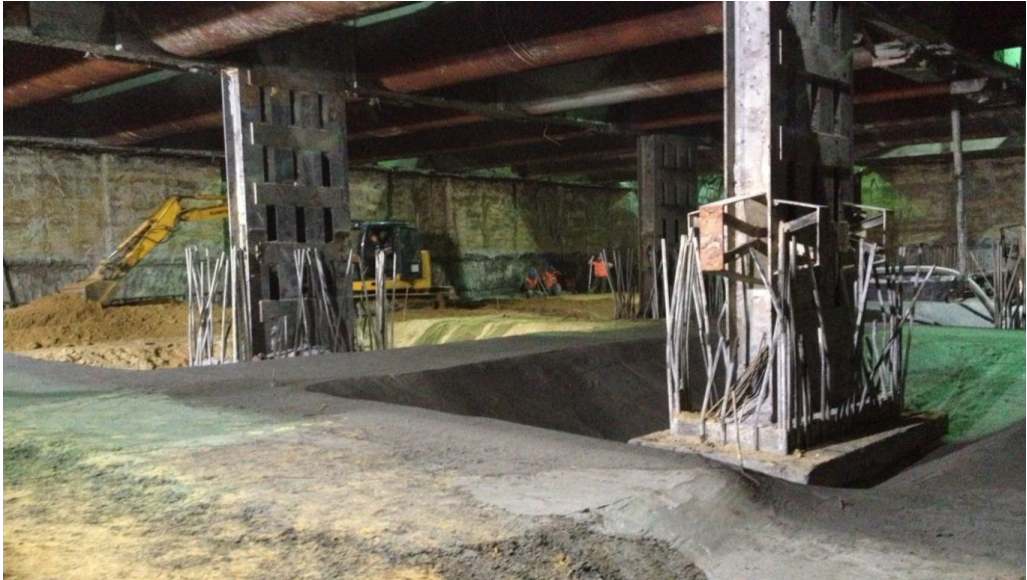
Şekil 5.56: Temel Döşeme İmalatı
