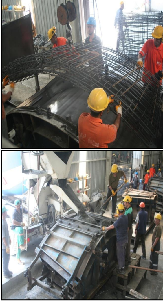
Şekil 3.11: Segment Donatılarının Özel Kalıba Konulup Betonunun Dökülmesi
