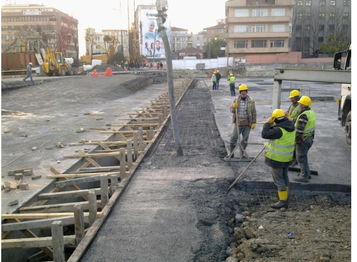
Şekil 5.22:Klavuz Duvar İmali
