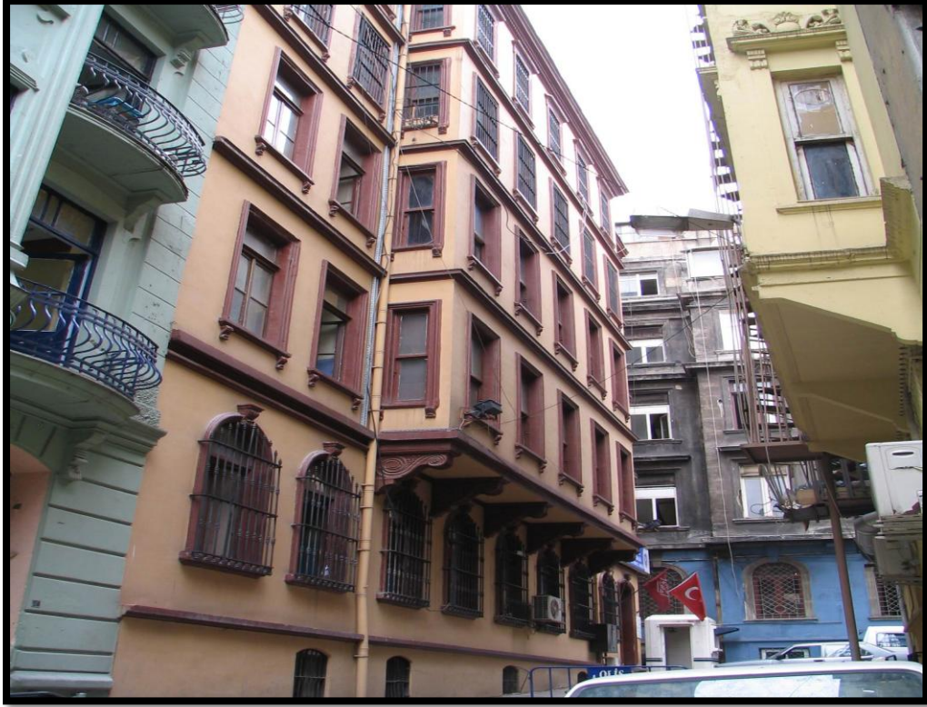
Şekil 4.14. : Yenileme uygulaması tamamlanmış bir yapı
