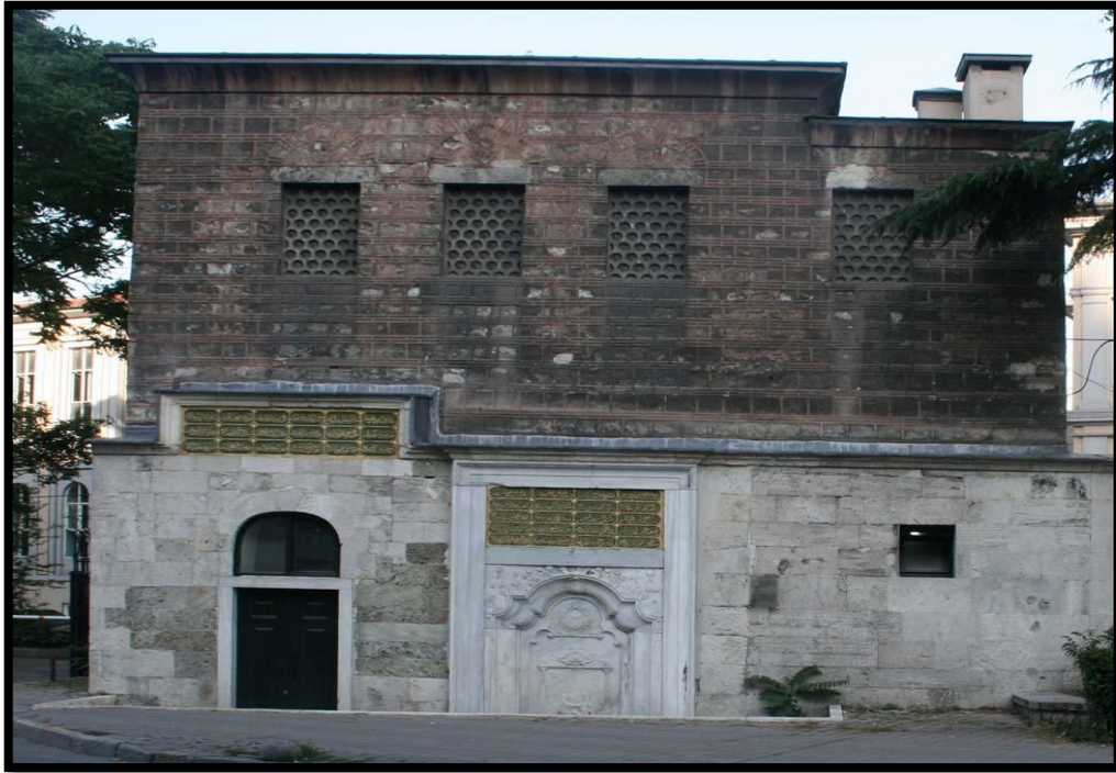
Şekil 4.13. : Yenileme uygulaması tamamlanmış bir yapı
