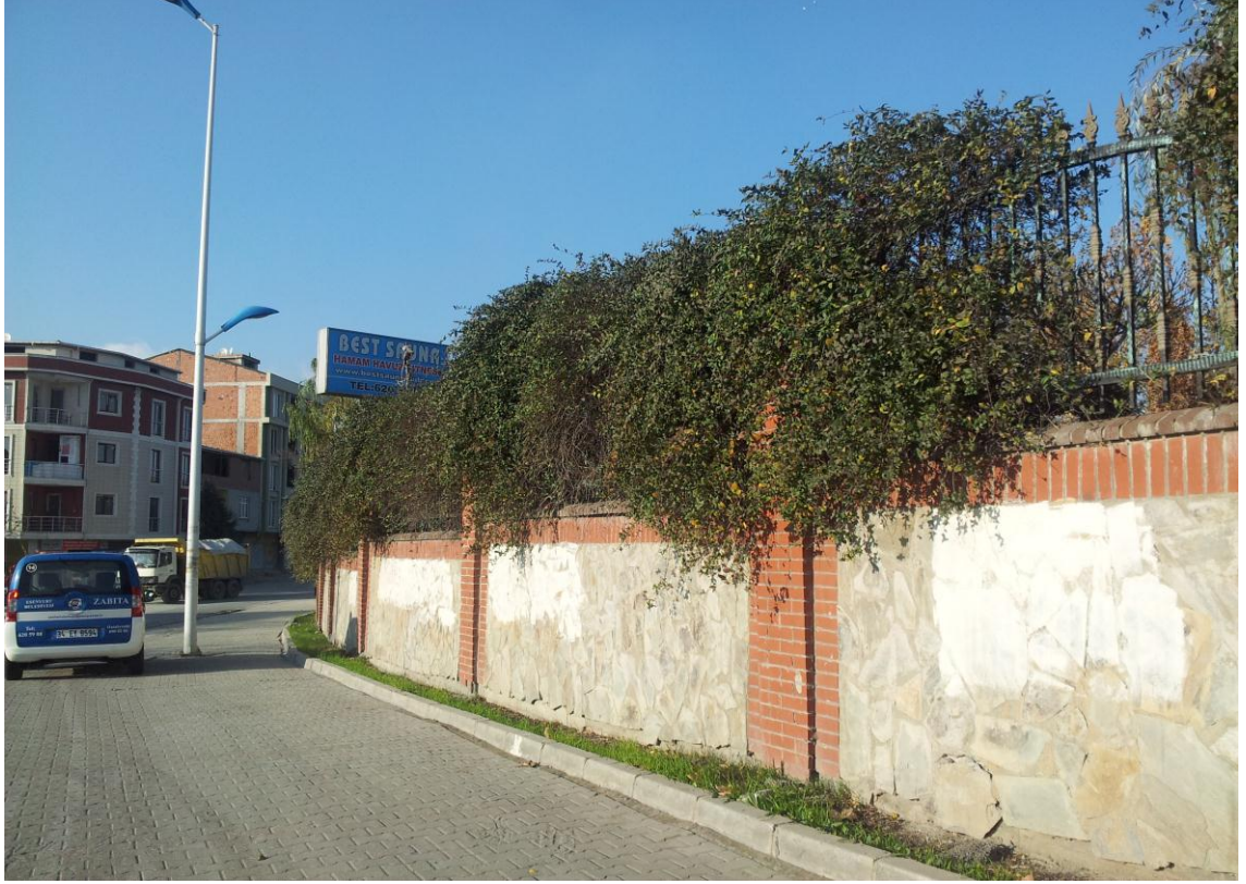
Şekil 8.15: RTE Şehir Parkı duvar üzeri sarılıcı bitki düzenlemesi (Yasemin)
