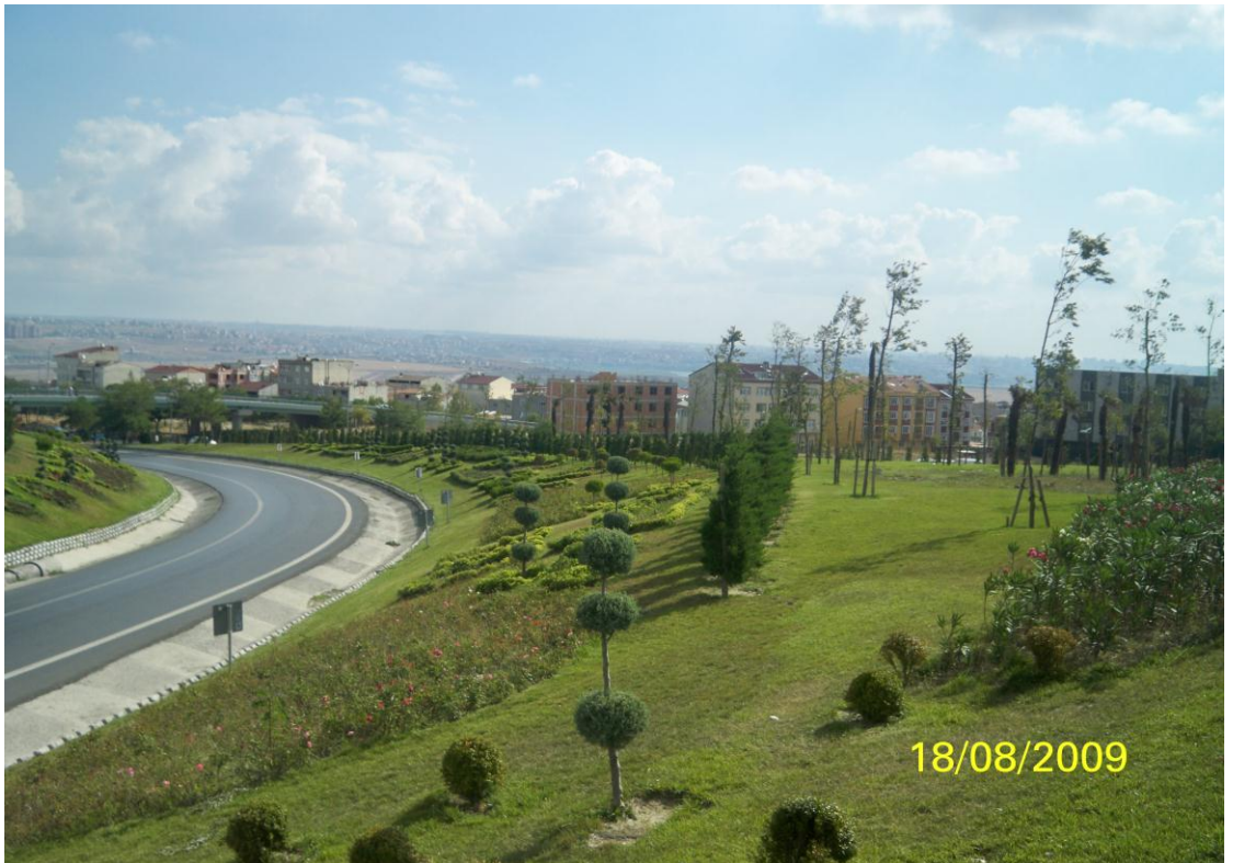
Şekil 8.73: TEM Bağlantı yolu Esenyurt girişi yol kenarı düzenlemesi 2
