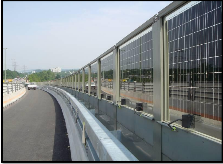
Şekil 6.7: Almanya’da kullanılan güneş enerjisi saydam gürültü bariyerleri
