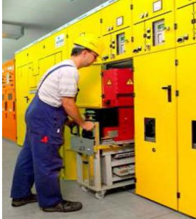
Şekil 4. 66: Gerapid tipi DC devre kesici
