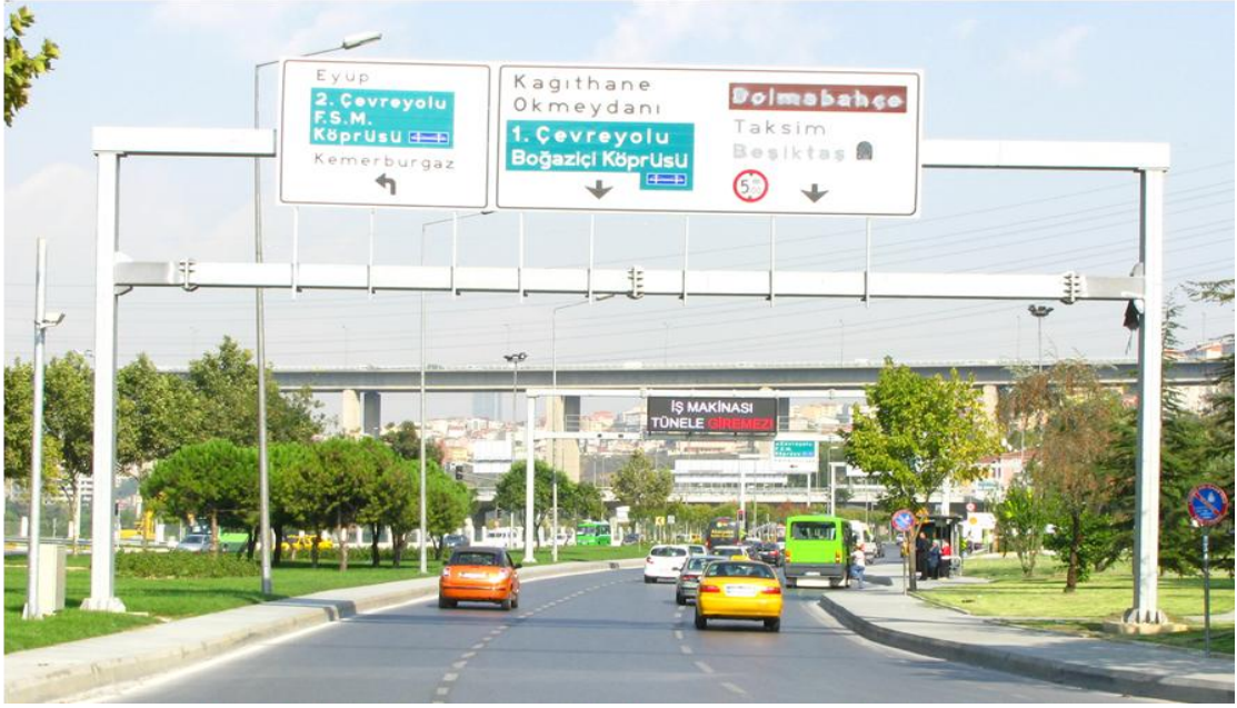
Şekil 6.14: Kağıthane – Dolmabahçe Tüneli trafik işaretlemeleri
