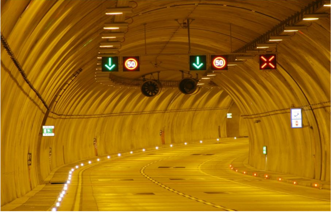
Şekil 6.3: Kağıthane – Dolmabahçe Tünelinden bir görünüş
