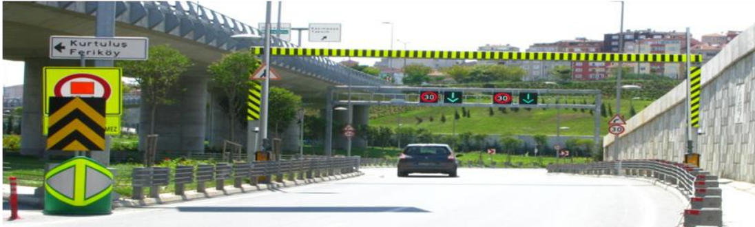
Şekil 6.16: Kağıthane – Dolmabahçe Tüneli Gabari Fiziki Engel
