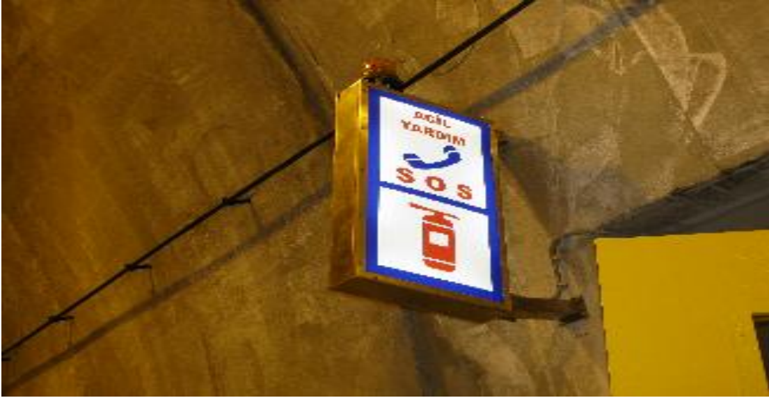
Şekil 6.8: Kağıthane – Dolmabahçe Tüneli trafik işaretlemeleri
