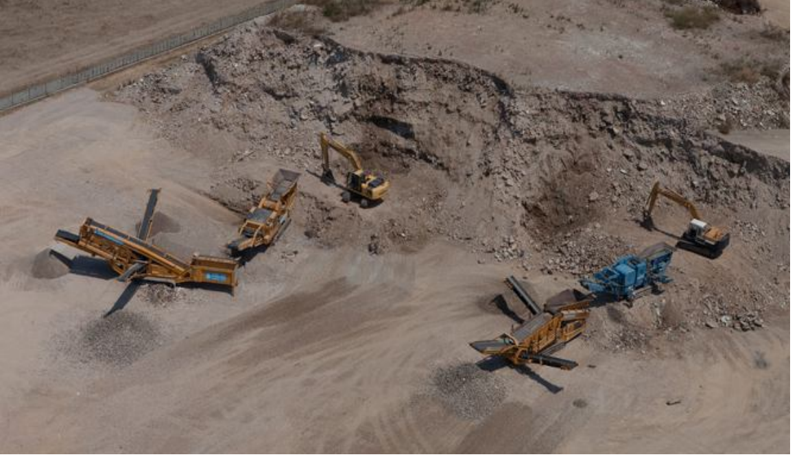
Şekil 4.5: Geri kazanım tesisi çalışırken
