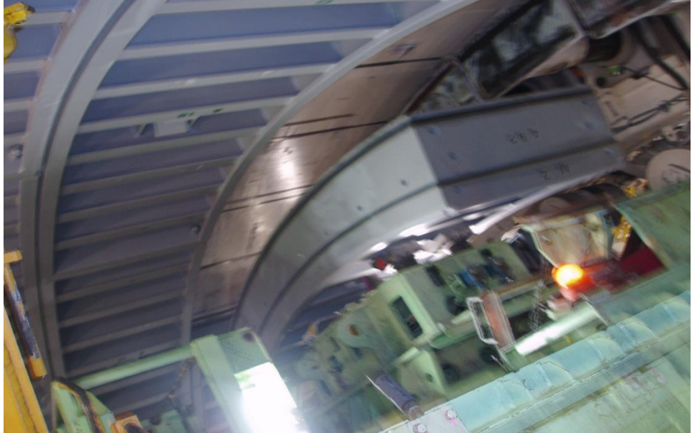
Şekil 4.25 : Segment montajı
