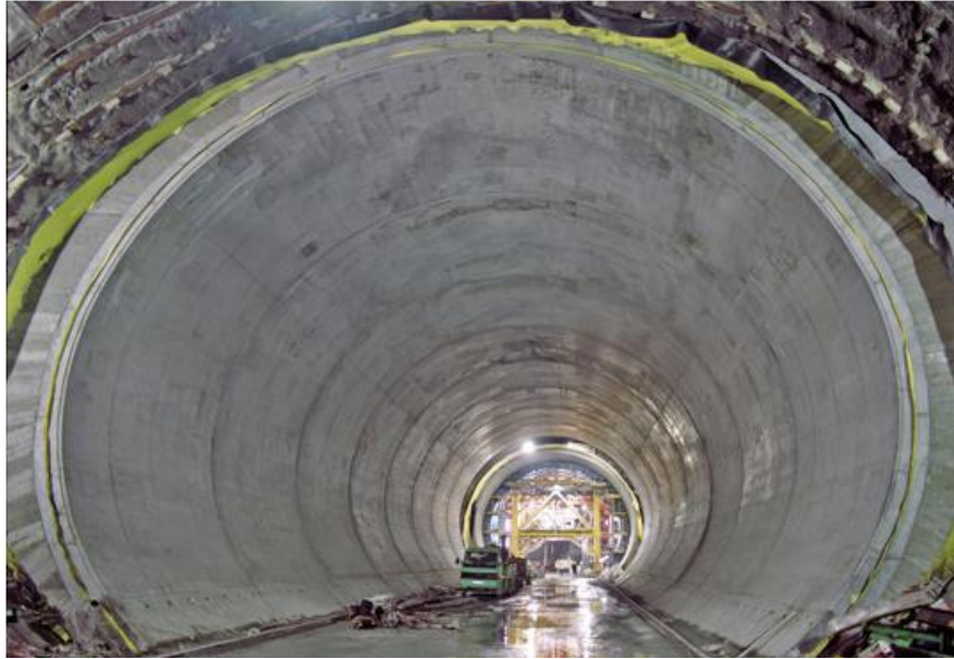
Şekil 4.31 : Üsküdar Makas Tüneli inşa halinde
