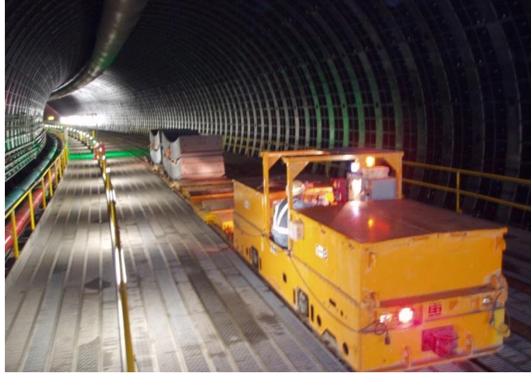
Şekil 4.24 : Segmentlerin tünel içerisinde nakliyesi
