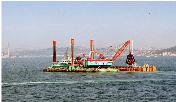
Şekil 4.6 : Hendek açma çalışmaları
