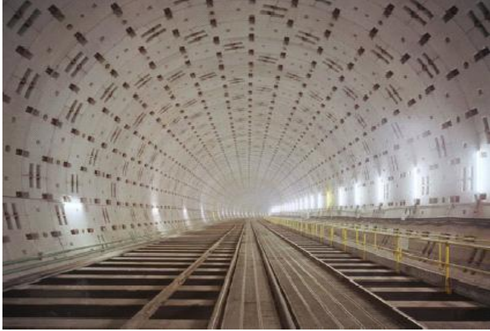
Şekil 4.26 : Tünelin ringler takılarak bitmiş hali
