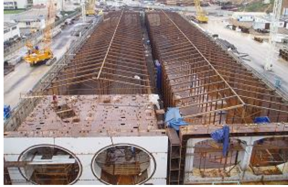
Şekil 4.11 : Batırma tüp tünel imalatı
