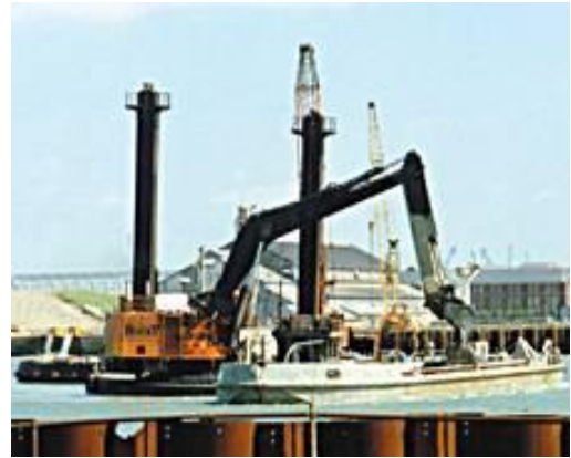
Şekil 3.10 : Taraklama çalışması
