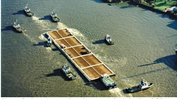
Şekil 3.11 : Yüzdürme işlemi
