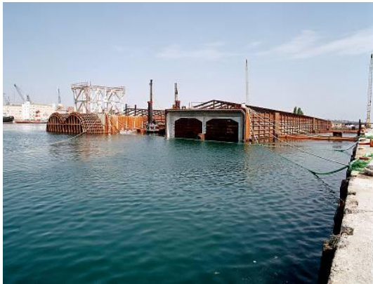
Şekil 4.11 : Batırma tüp tünel imalatı
