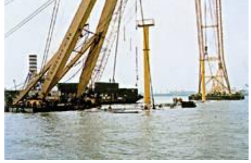
Şekil 3.12 : Tüp tünel batırma işlemi
