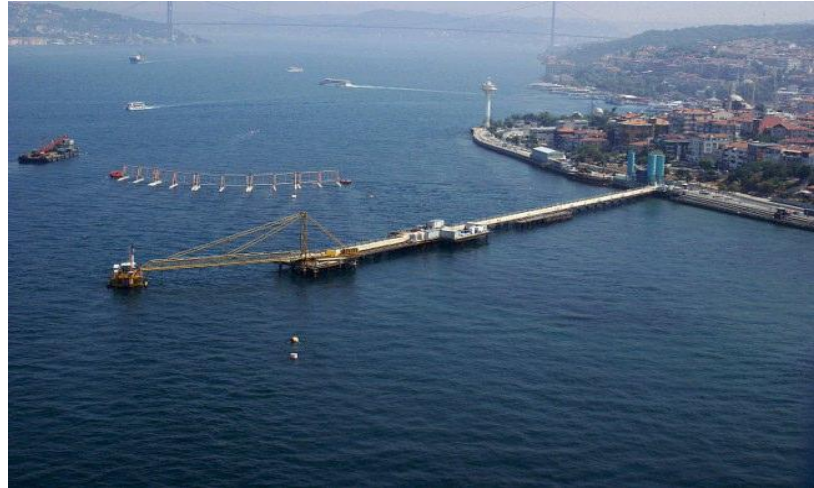
Şekil 4.17 : Tüp tünele ulaşım şaftı,Üsküdar
