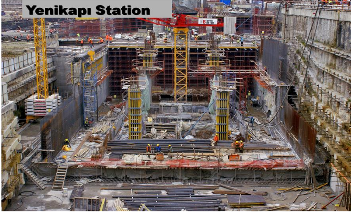
Şekil 4.38 : Yenikapı İstasyonu inşaat çalışması
