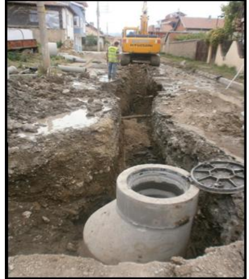
Şekil 3.2: Açık Kazı Kanalizasyon Baca Yapımı Çalışması
