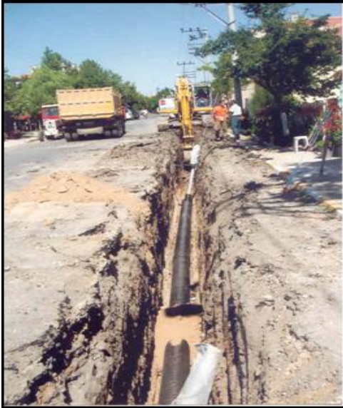
Şekil 3.1: Açık Kazı İle Kanalizasyon Çalışması
