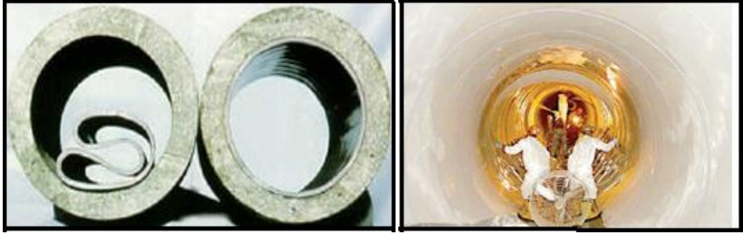
Şekil 3.20: Katla ve Şekil Ver Astarlama
