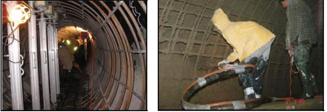
Şekil 3.16: Harç Kaplama
