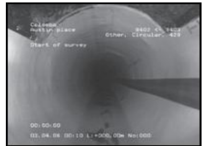
Şekil 3.19: Astarlama Sonrası
