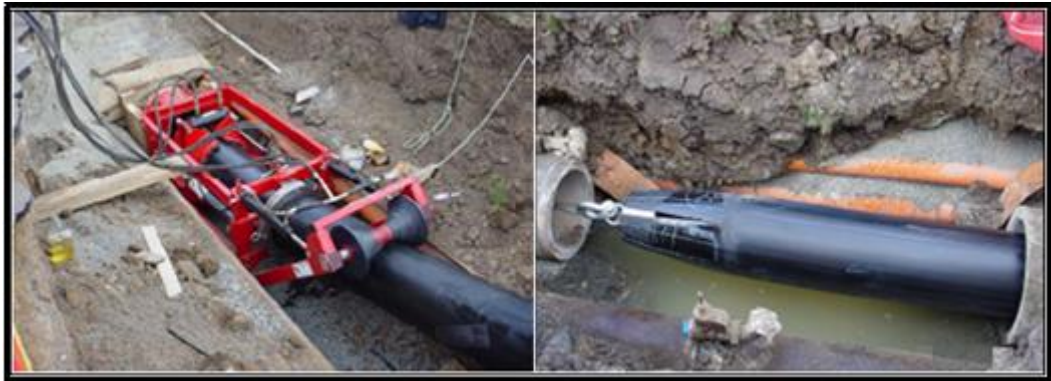
Şekil 3.17: Kaymalı Astarlama
