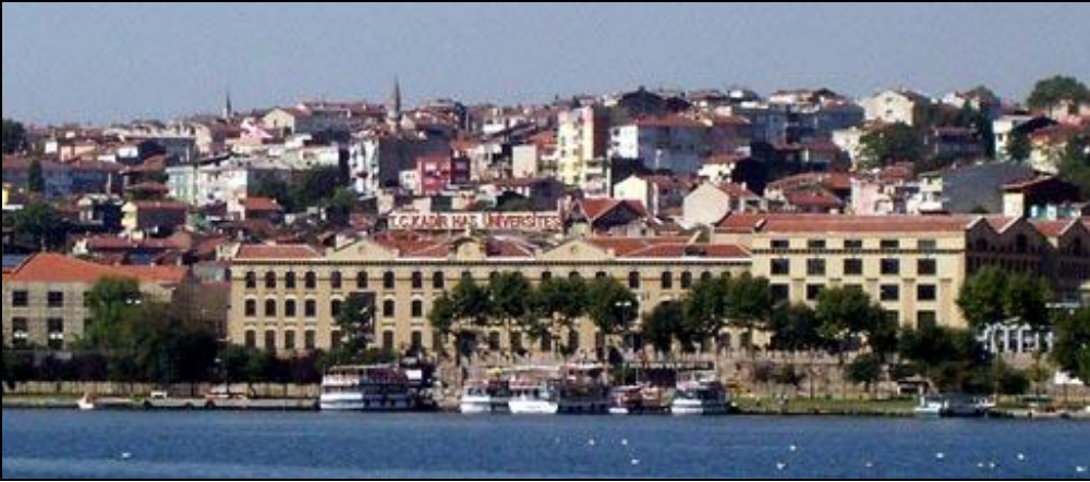
Şekil 4.24:Eski Cibali Tütün ve Sigara Fabrikası Yeni Durumu
