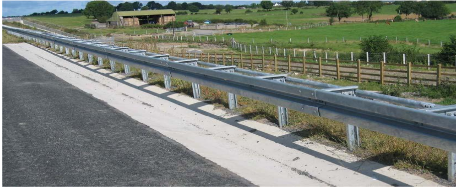
Şekil 1.1: Karayolu çelik otokorkulukları ve yapı elemanları
