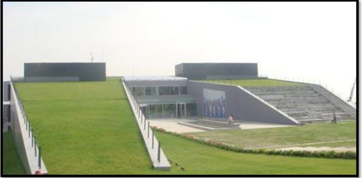
Şekil 3.42: Turkcell Arge binası, Gebze
