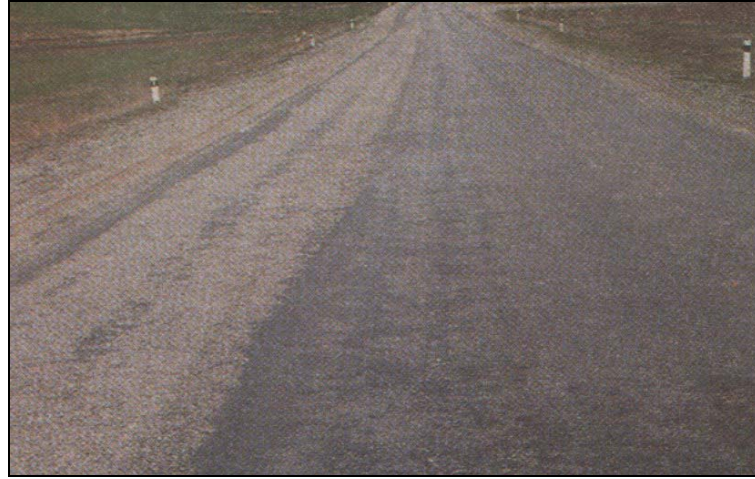
Şekil 4.42 : Yüksek şiddette ayrışma ve sökülme
