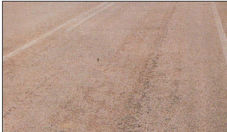
Şekil 4.41 : Hafif şiddette ayrışma ve sökülme
