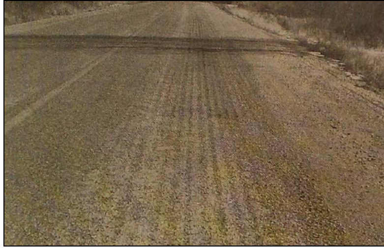
Şekil 4.44 : Orta şiddette çizgisel agregaya kaybı
