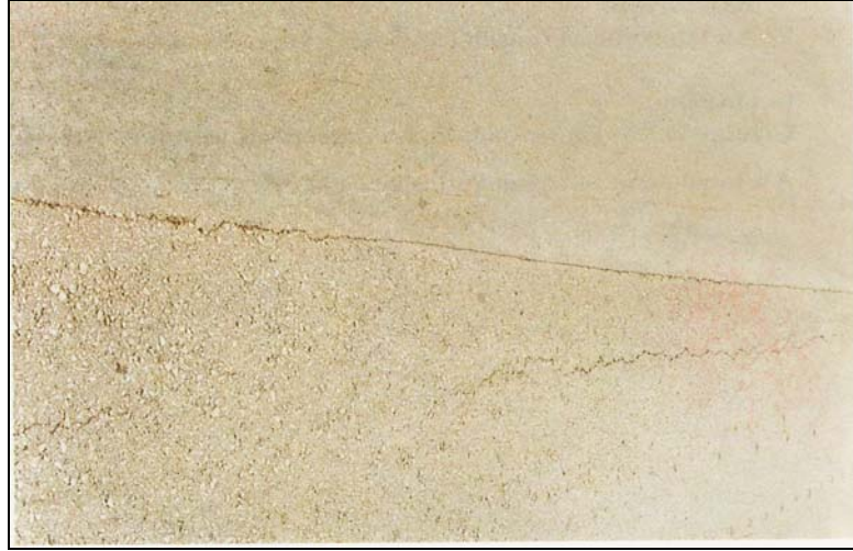
Şekil 4.28 : Genişletme çatlağı
