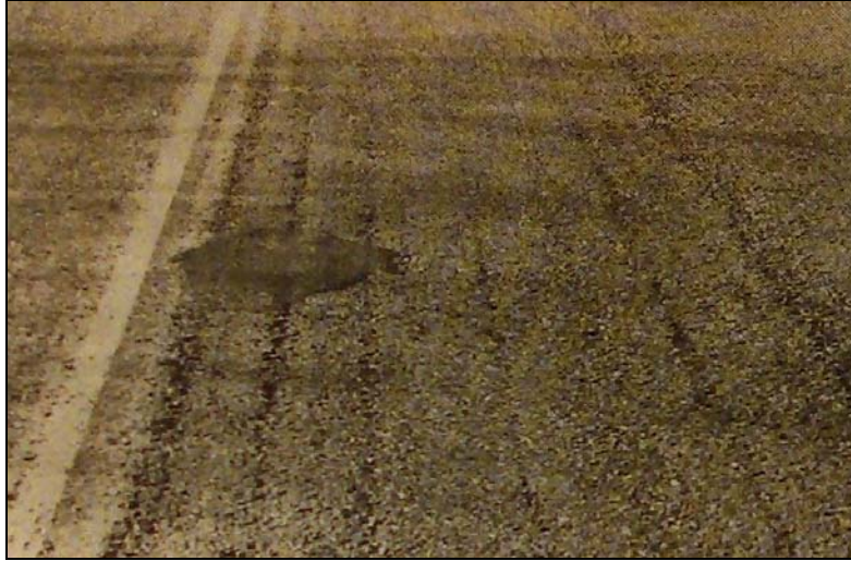
Şekil 4.45 : Yüksek şiddette çizgisel agregaya kaybı
