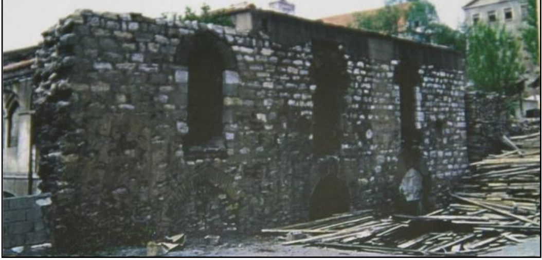
Şekil 5.6: Restorasyondan önceki hali
