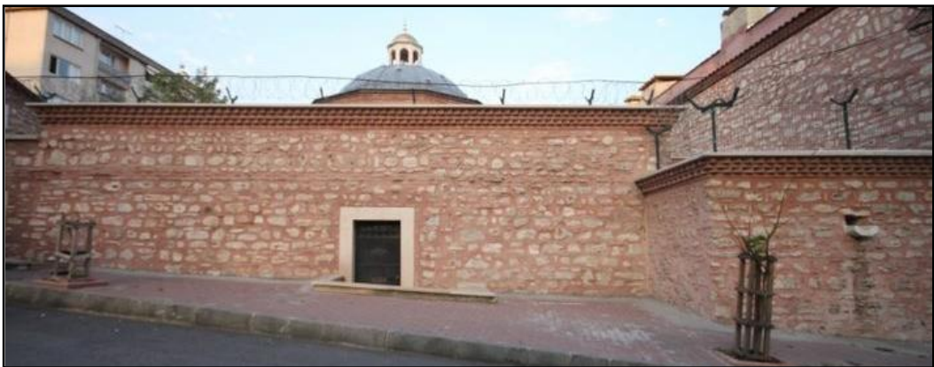
Şekil 5.8: Restorasyon sonrası ılıklık duvarı
