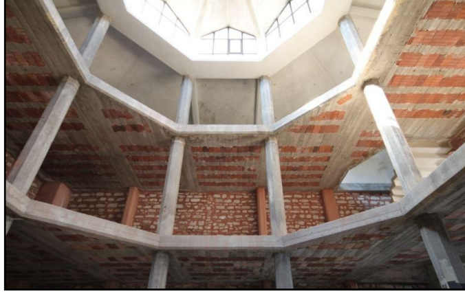
Şekil 5.9: Soyunmalıktaki betonarme ara katlar
