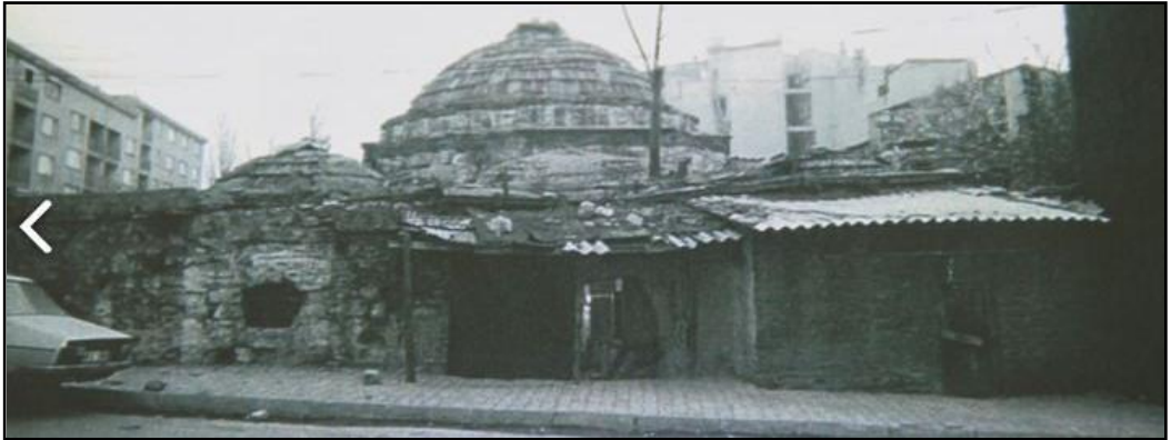
Şekil 5.7: Restorasyon öncesi ılıklık duvarı
