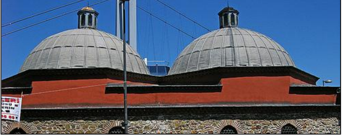
Şekil 6.8: Çatı fenerleri
