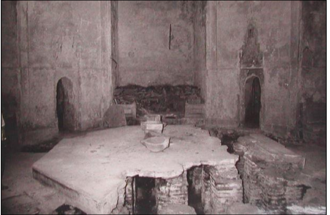
Şekil 5.34: Restorasyon öncesi sıcaklığın durumu
