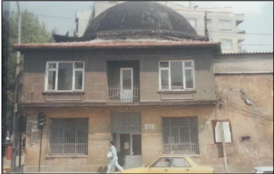
Şekil 6.4: 80'li yıllarda hamamın ön cephesi
