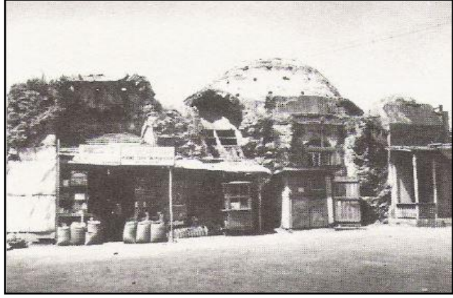
Şekil 5.44: Hamamın restorasyon öncesi görünümü
