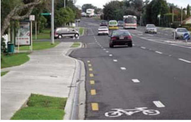
Şekil 4.18: Yaya kaldırımının yanına inşa edilmiş bisiklet yol örneği
