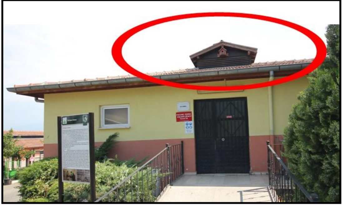
Şekil 4.14: Doğal ışık ve havalandırma için yapılmış olan çatı müdahalesi
