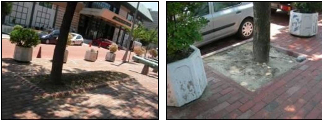
Resim 5.124: Çalışma alanında bulunan peyzaj elemanlarının yerleşimindeki düzensizlik sonucu oluşan engeller
