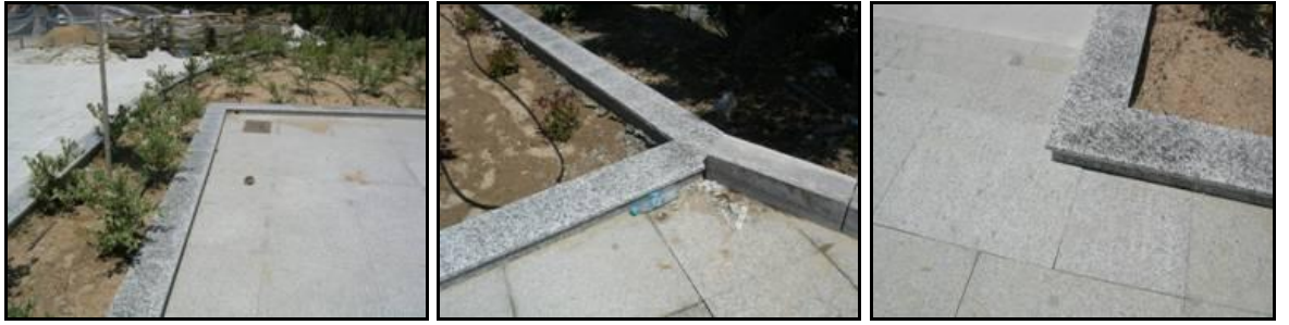
Resim 5.40: Çalışma alanından bazı birleşim detayları
