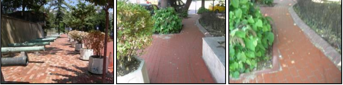
Resim 5.37: Kaldırımda bulunan donatıların erişimi engellemesi
