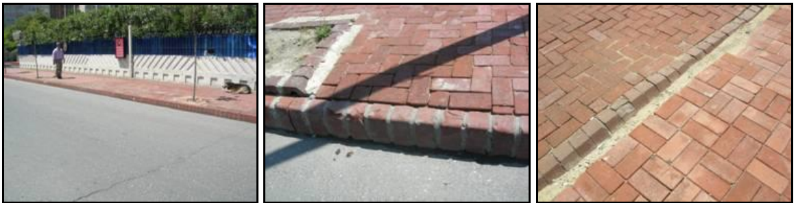
Resim 5.43: Çalışma alanından bazı yaya yolu görüntüsü ve birleşim detayları
