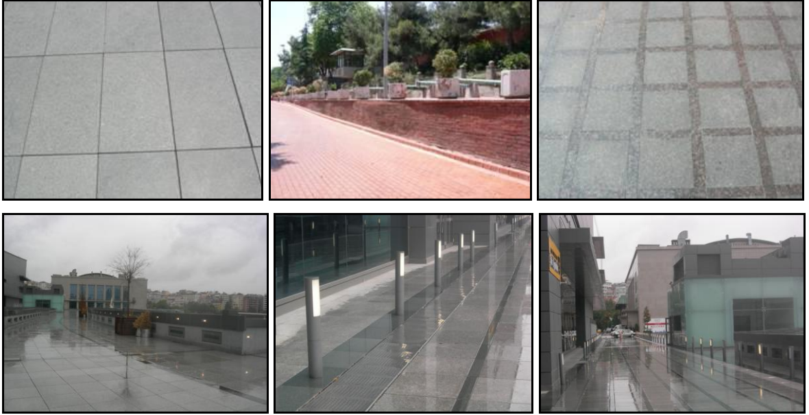
Resim 5.42: Çalışma alanından bazı zemin yüzey örnekleri ve yağışta oluşan kaygan yüzey
