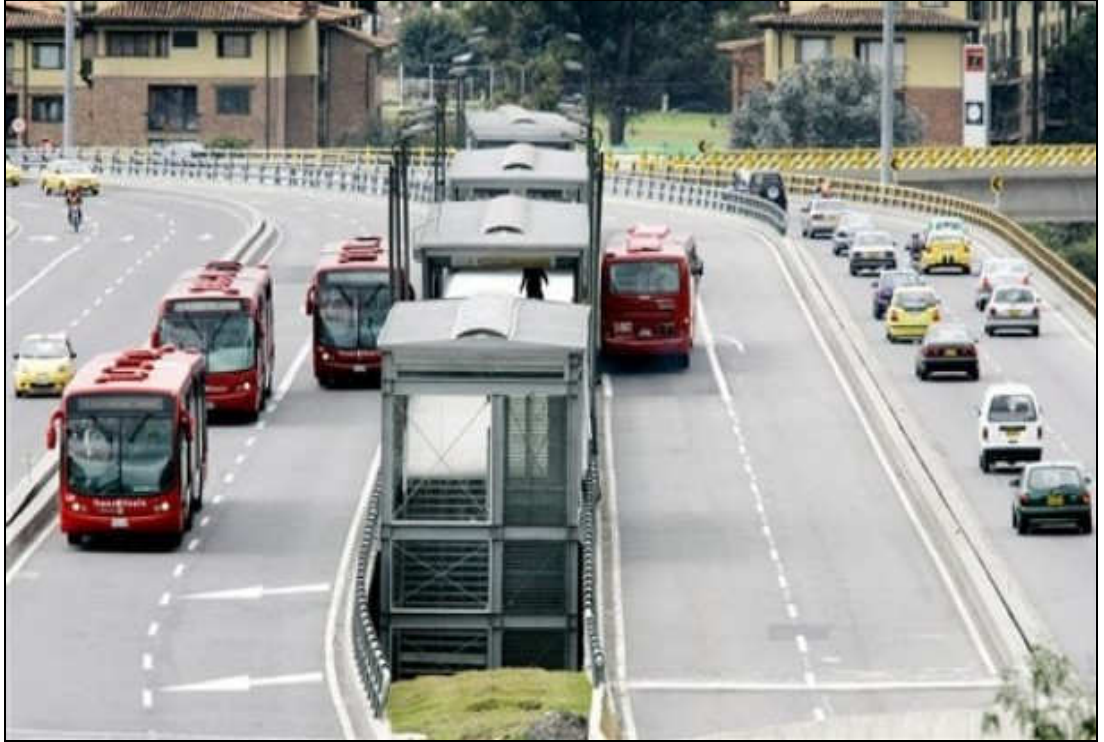
Şekil.31.1 Çift şeritli Metrobüs hattı. (Kolombiya/Bogota-Transmilenio)
