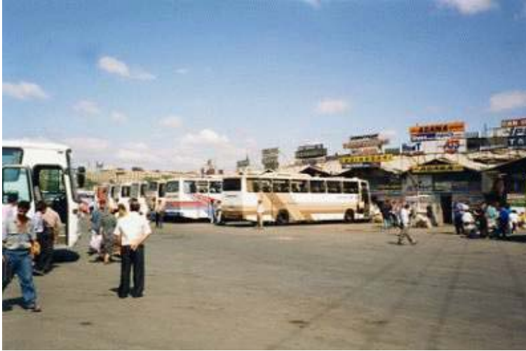
Resim 3.7: İstanbul Topkapı Eski Otogarı Görünüş
