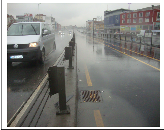
Şekil 6.4: Yağışlı havalarda metrobüs yolunda meydana gelen göllenmeler
