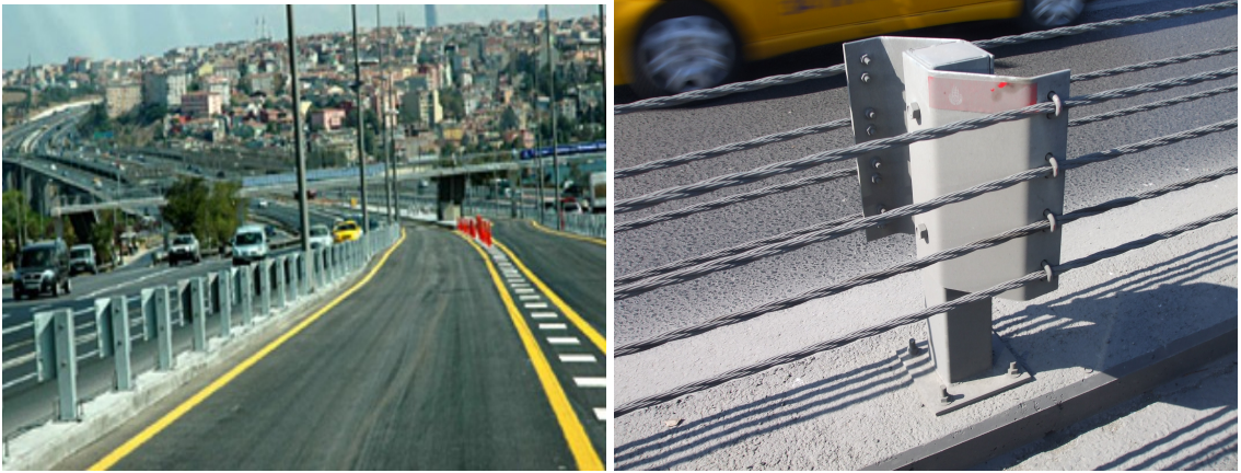
Şekil 6.1: Tek yönlü ve Çift yönlü çelik halatlı otokorkuluk sistemleri
