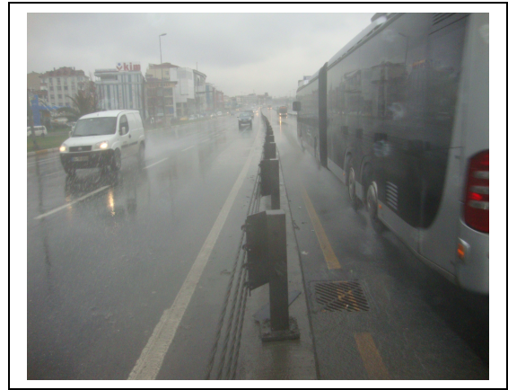
Şekil 6.4: Yağışlı havalarda metrobüs yolunda meydana gelen göllenmeler
