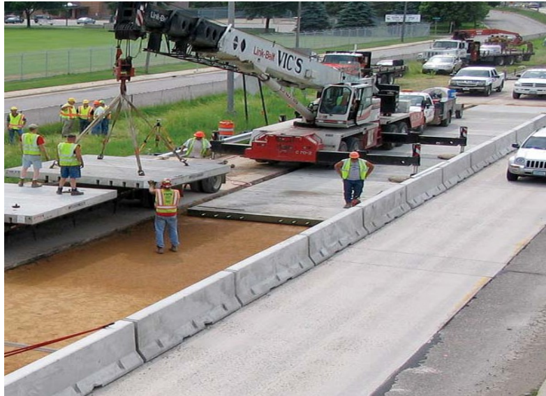
Şekil 8.1: Çift yönlü new jersey tipi otokorkuluk sistemi
