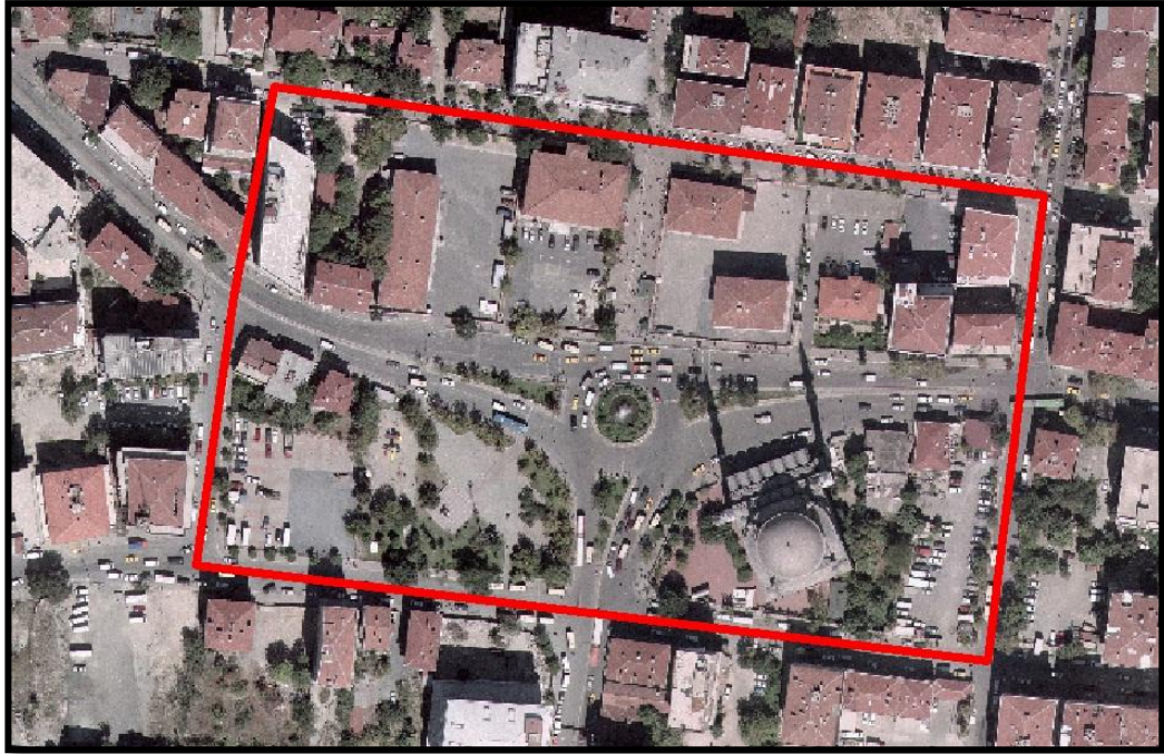
Şekil 5.5: Bağcılar Meydanı Transfer Merkezinin Mevcut Durumu
