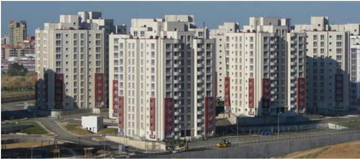
Şekil 3.21: Oyak Kent Konutlarından bir görünüş.
