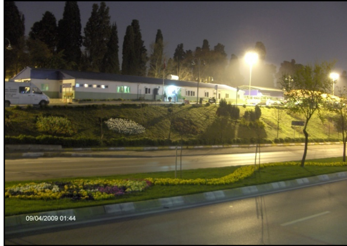
Şekil 5.170 : Müdür yardımcılığı hizmet binası gece aydınlatması
