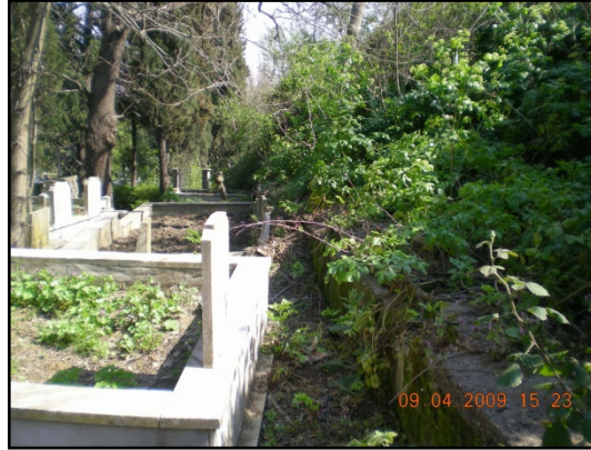
Şekil 5.103: 5. adanın güney duvarları
