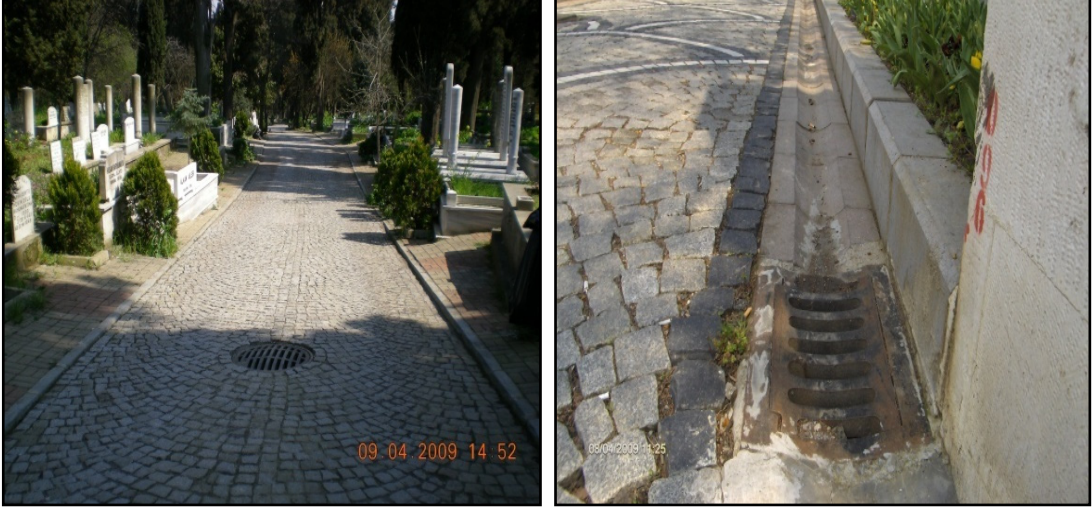
Şekil 5.176 : Mezarlıktaki yağmursuyu kanalları
