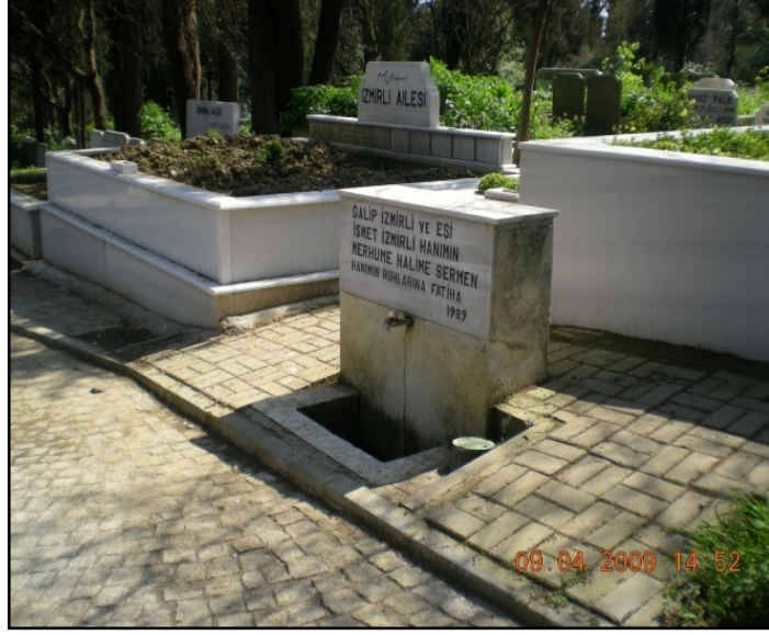
Şekil 5.185: Çeşme yanına kuyu kaplink tesisatı kurulmuş
