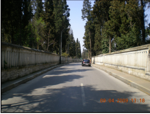
Şekil 5.97 : 9.ve 10. ada duvarları
