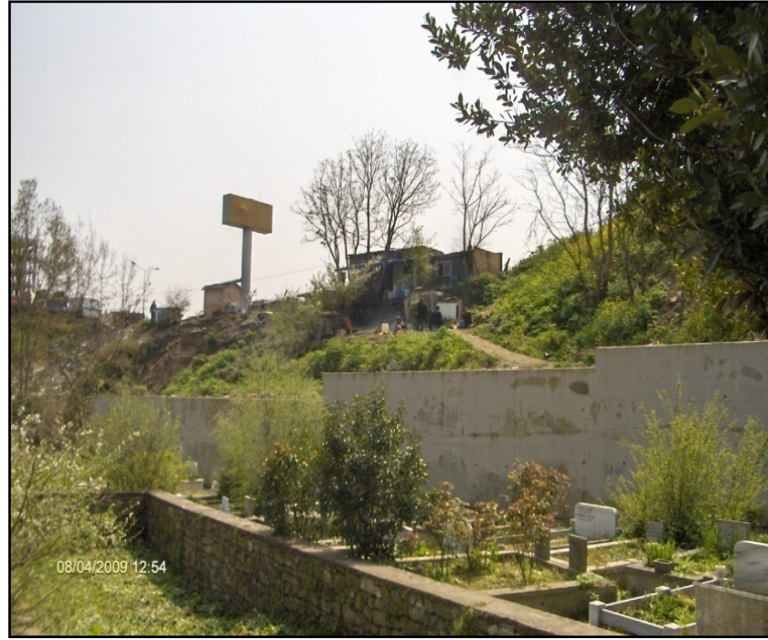
Şekil 5.182: Perdeleme ve yer örtücü kullanılması gereken şev
