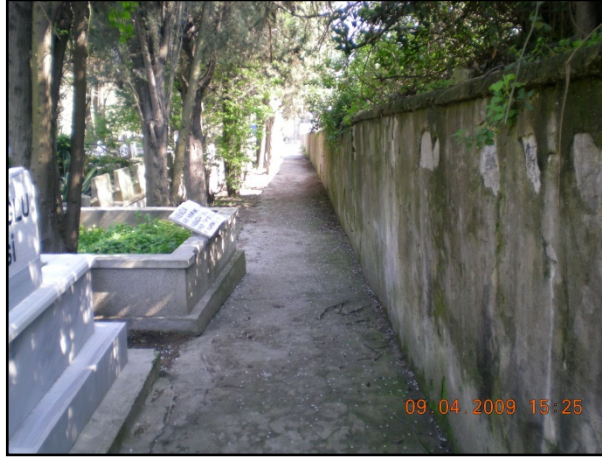
Şekil 5.100: 5. adanın batı duvarları
