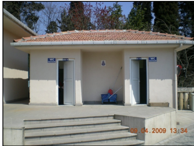
Şekil 5.149 : Gasilhane ve morg binasının yanındaki wc
