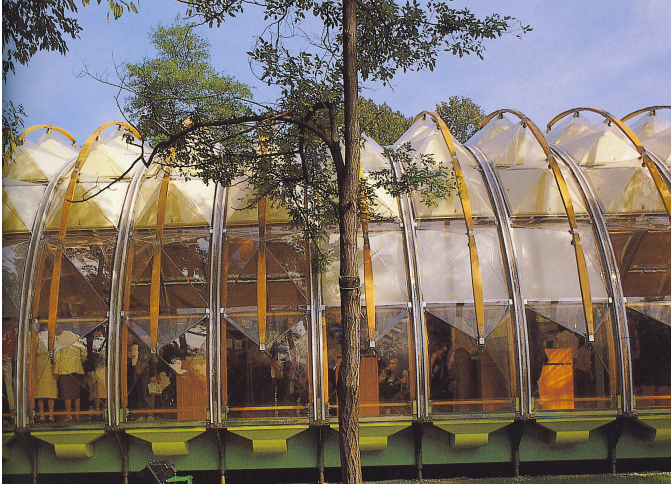
Şekil 43 : IBM Seyyar Pavyonu, Taşıyıcı Cam Plakalar
