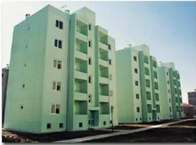
Şekil 98. Deprem konutları ekonomiklik açısından tünel kalıp ile imal edilmiştir. (Kaynak: http://www.akfen.com.tr/akfen/tur/grup/ins/konutimgdep.htm )
