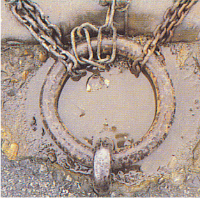
Şekil 30. Çadır Yapılarında Dayanımından Dolayı Tercih Edilen Çember Şekli ( Kaynak: Renzo Piano Building Workshop, Phaidon, Volume One, 2001, Sayfa102 )
