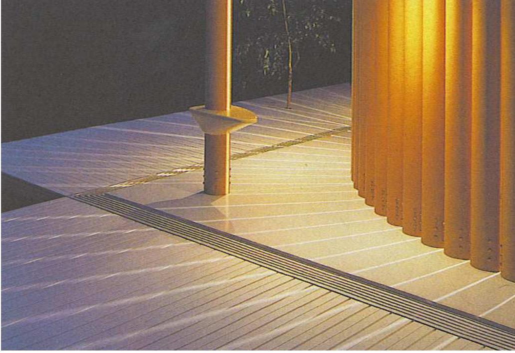
Şekil 74. Dolu Yüzey Kâğıt Silindirlerin Yapı Elemanı Olarak Kullanılmaları (Kaynak: Domus M, 2 Aralık – Ocak, 1N HEARST, Sayfa 40)
