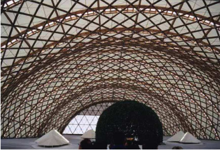
Şekil 69. Güncel Tonoz Yapısı, Japon Pavyonu
