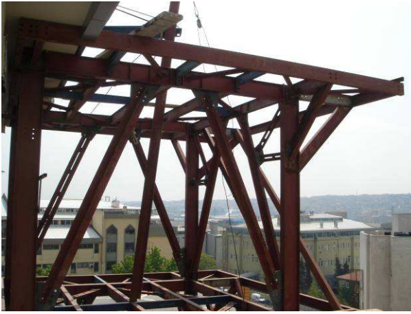
Şekil 53. Şen Deri ve Konfeksiyon Fabrika Binası Çelik Platform İmalatı, Yenibosna, İstanbul
