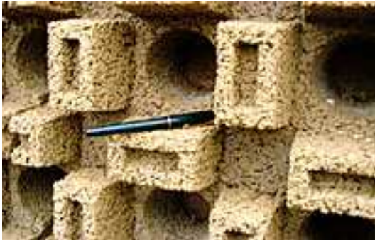
Fotoğraf 10- Rezonatör tipli beton blok duvar uygulamaları
