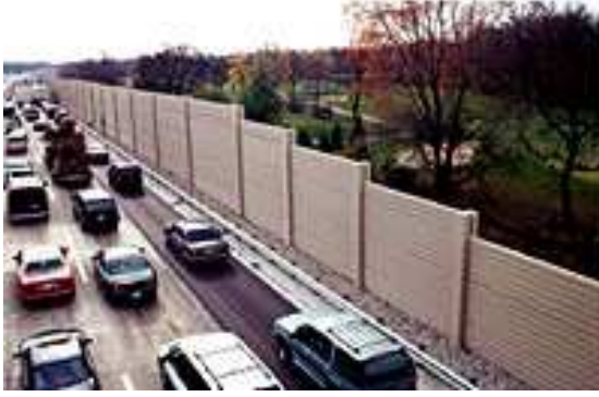
Fotoğraf 5- Beton duvar örneđi (Prefabrike elemanlar)
