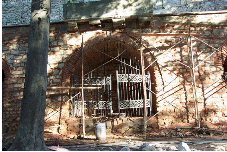
Şekil 5.7. Topkapı Sarayı'nın yıkılan duvarının restorasyon çalışması.
