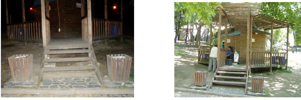
Şekil 5. 32. Tuvalet girişindeki merdiven görüntüleri
