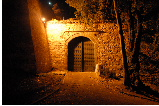
Şekil 5.12.Tarihi kapı girişi ve aydınlatma durumu
