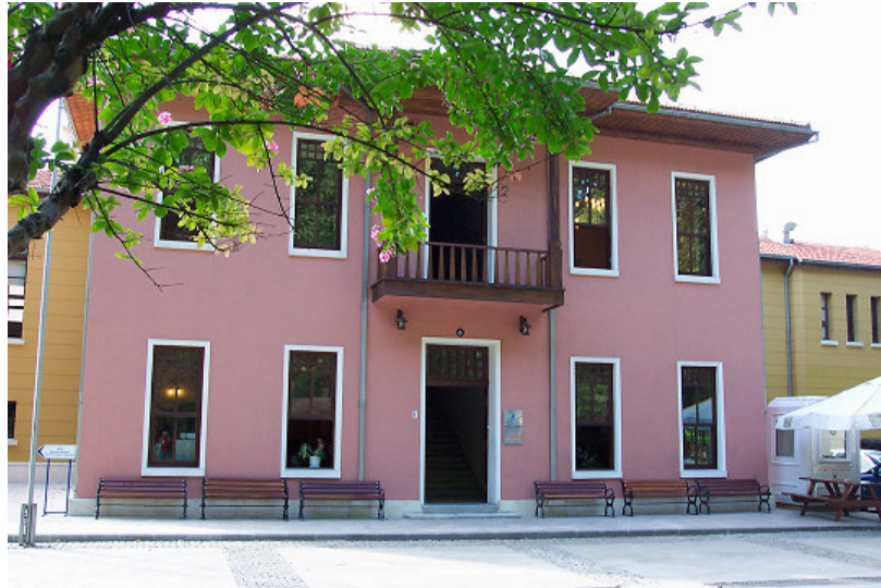
Şekil 5.8 Restorasyon çalışmalarından sonra İstanbul Turizm Atölyesi'ne dönüştürülen bina.
