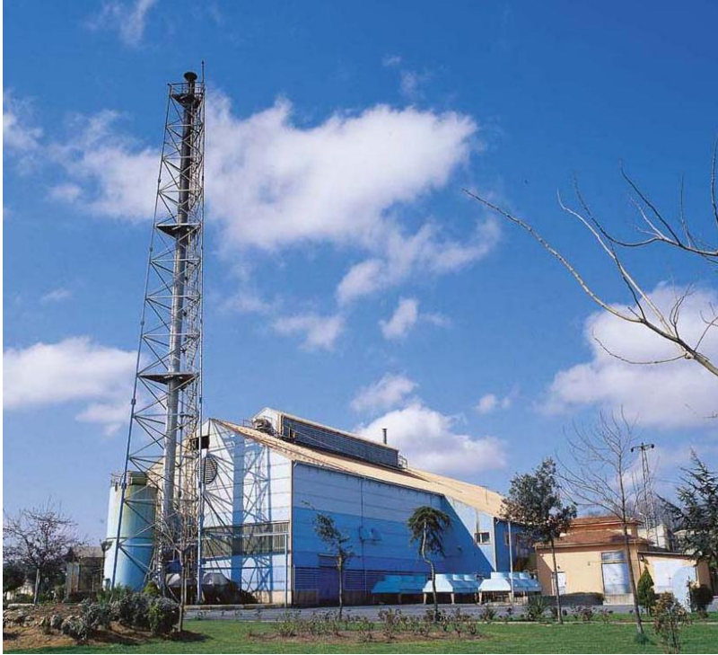
Şekil 5.5: Tıbbi atık yakma tesisi
