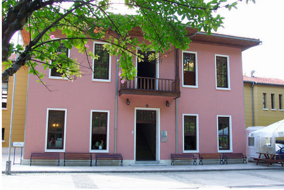
Şekil 4.20. Yeniden düzenleme çalışmalarından sonra İstanbul Turizm Atölyesi'ne dönüştürülen eski Park ve Bahçeler Müdürlüğü binası.
