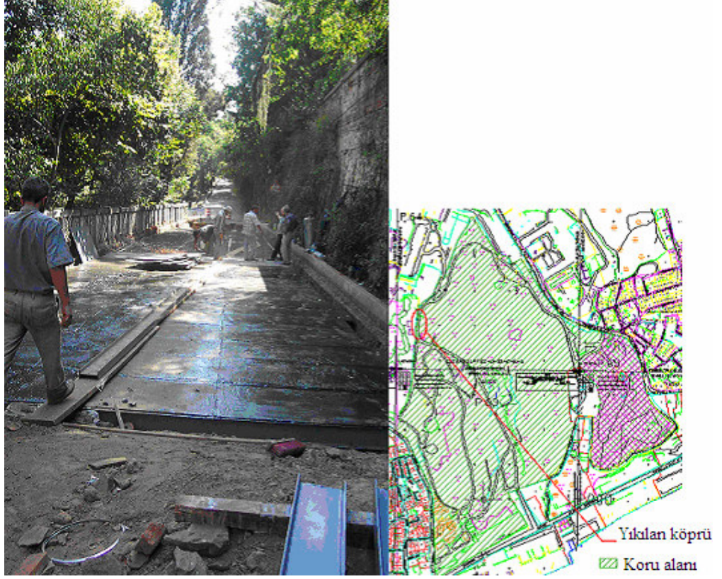
Şekil 4.35. Koruda Yıldız Köşküne giden yol üzerinde çöken köprünün onarım çalışmaları.
