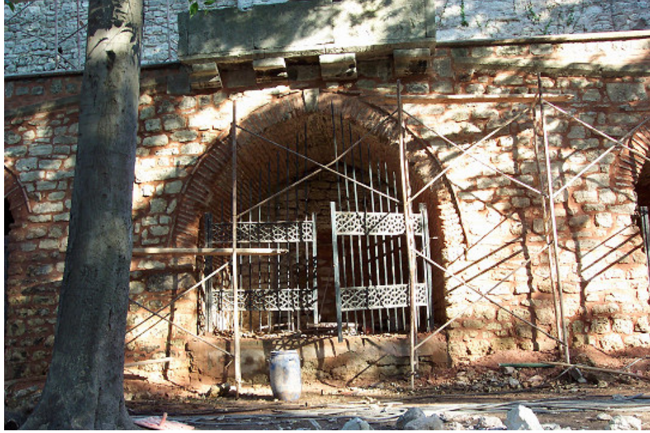
Şekil 4.19. Topkapı Sarayı'nın yıkılan duvarının Gülhane Korusu içinde yürütülen restorasyon çalışması.
