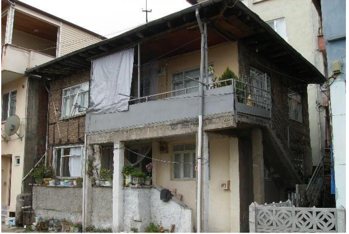
Şekil 5. 6. Bölgedeki ahşap binalara örnek
