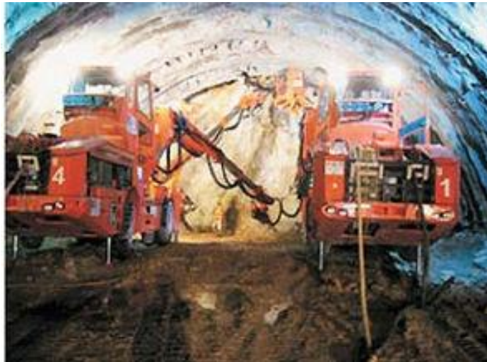
Şekil 1.3: Jumbo aygıtıyla tünel açılması
