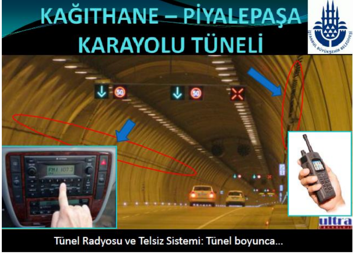
Şekil 4.12: Kağıthane - Piyalepaşa Tüneli radyo sistemi
