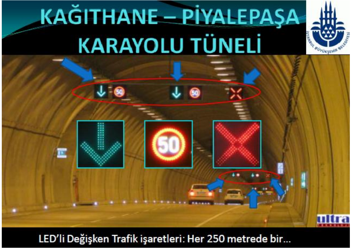
Şekil 4.10: Kağıthane - Piyalepaşa Tüneli trafik işaretleri sistemi
