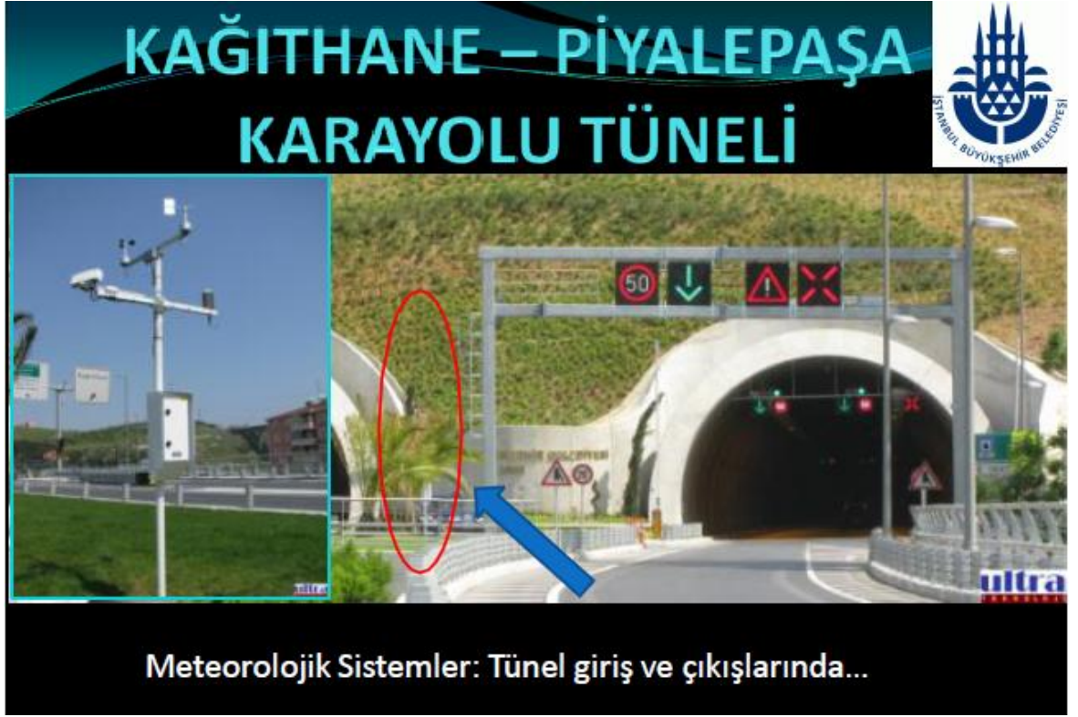
Şekil 4.14: Kağıthane - Piyalepaşa Tüneli meteorolojik sistemleri
