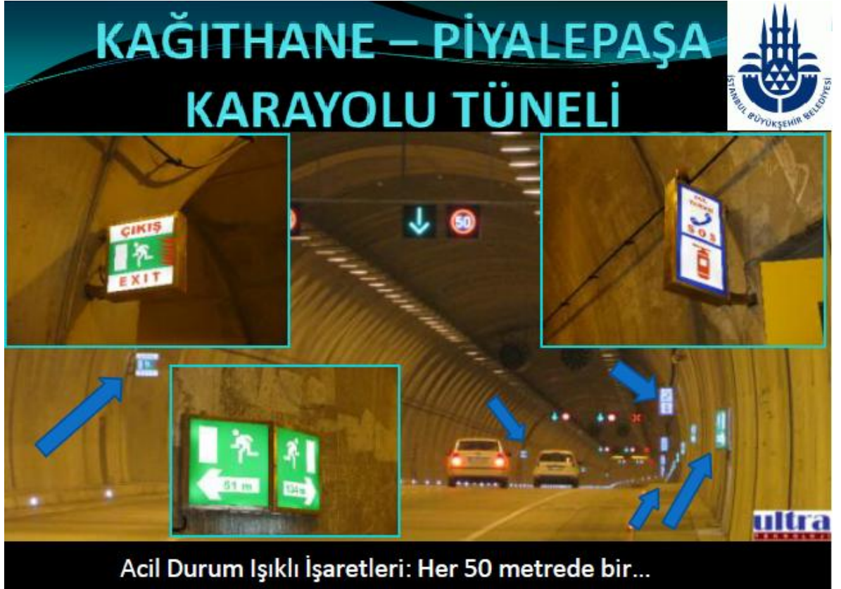
Şekil 4.11: Kağıthane - Piyalepaşa Tüneli acil durum sistemi
