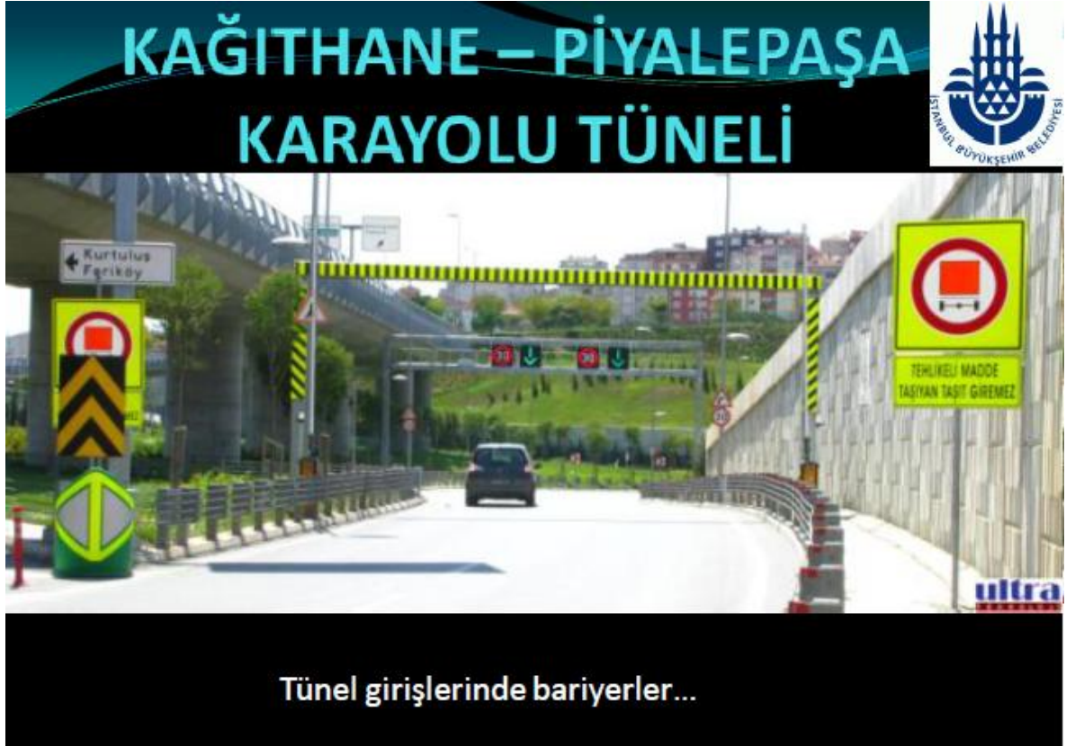
Şekil 4.5: Kağıthane - Piyalepaşa Tüneli giriş bariyer sistemi
