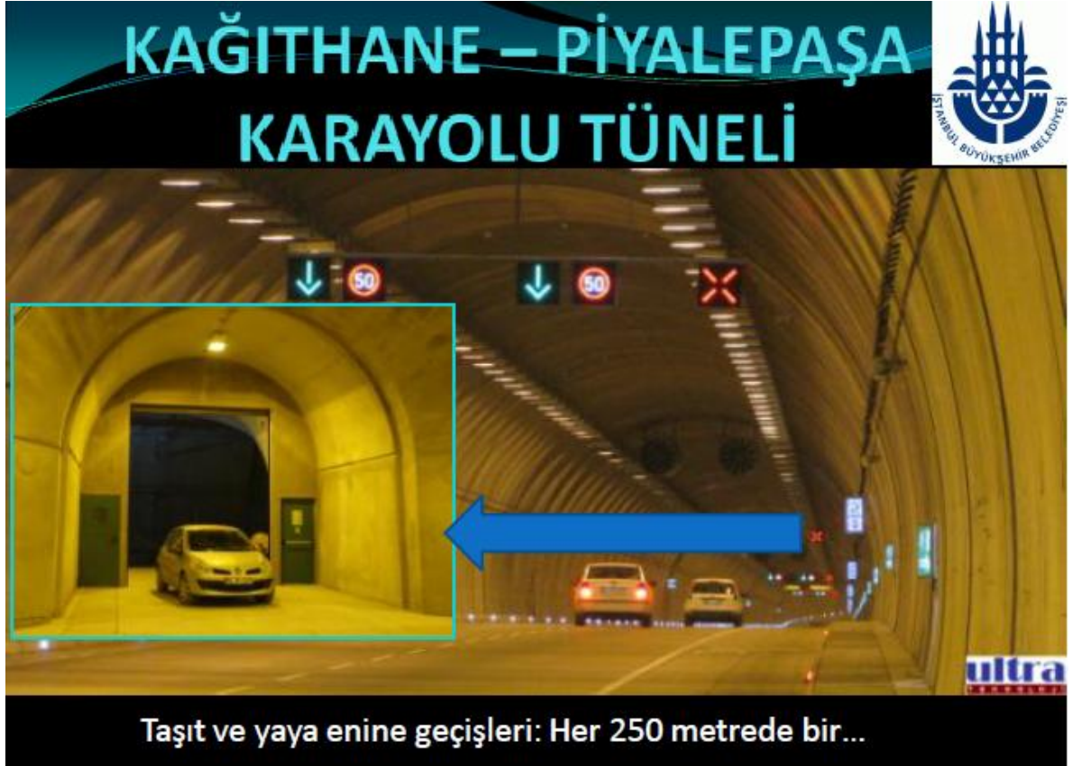
Şekil 4.13: Kağıthane - Piyalepaşa Tüneli enine geçiş sistemi
