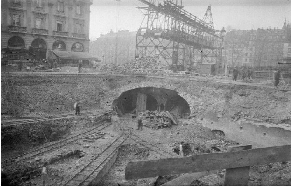
Şekil 1.13: Paris metrosu tüneli inşaatı (1902-1910)
