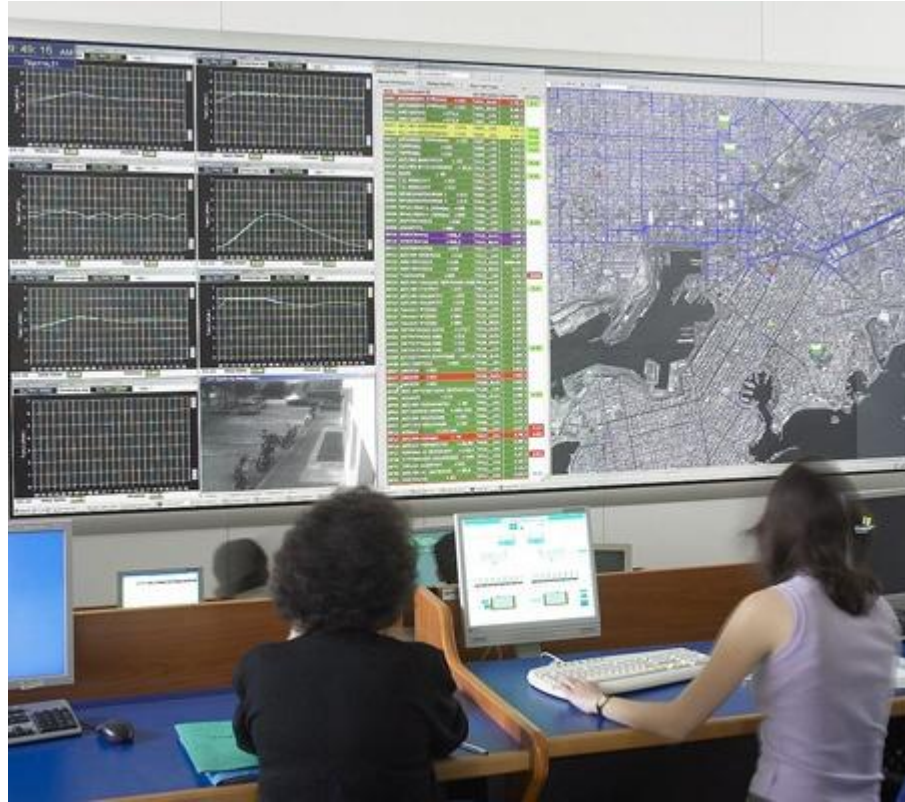
Şekil.5.42: Georgia Trafik Kontrol Merkezi Sistem Odası
