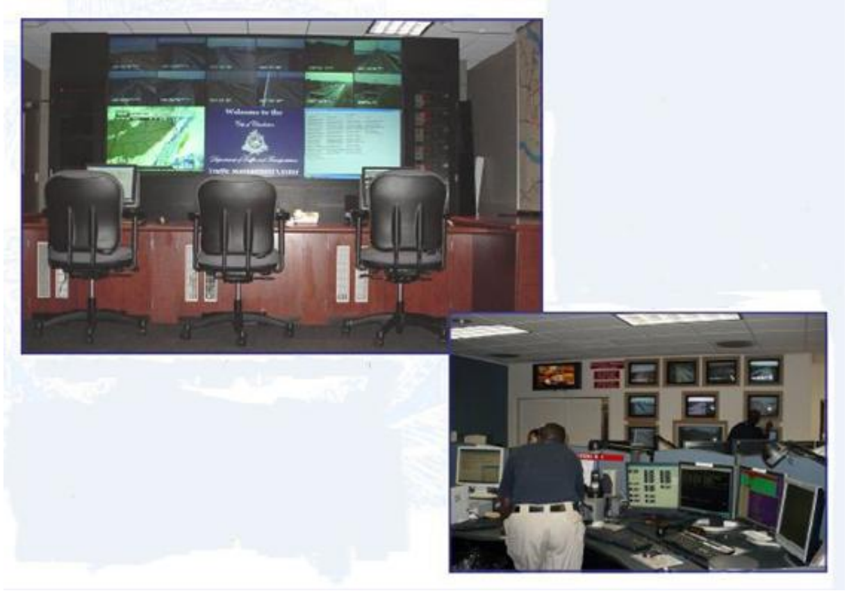
Şekil.5.39: Charleston Trafik Kontrol Merkezi
